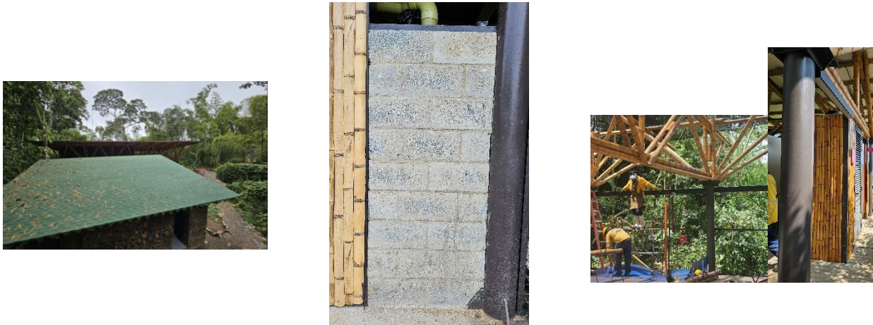
Figura 5. Imágenes representativas de los materiales más utilizados en el Proyecto. a) Guadua, b) Superboard, c) Madera inmunizada, d) Shingle, e) Bloques de concreto y f) Elementos metálicos.
