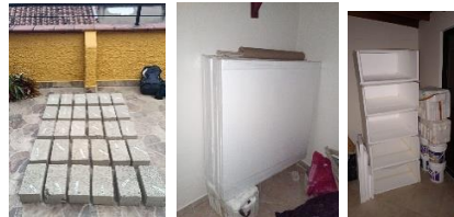
Figura 35. Armado de las Hot Box y traslado de BTC.
