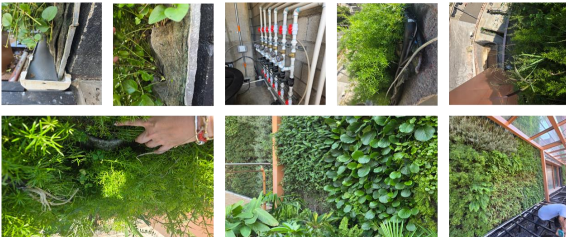
Figura 24. Sistema constructivo jardines verticales Florida Parque Comercial. Fuente propia.
