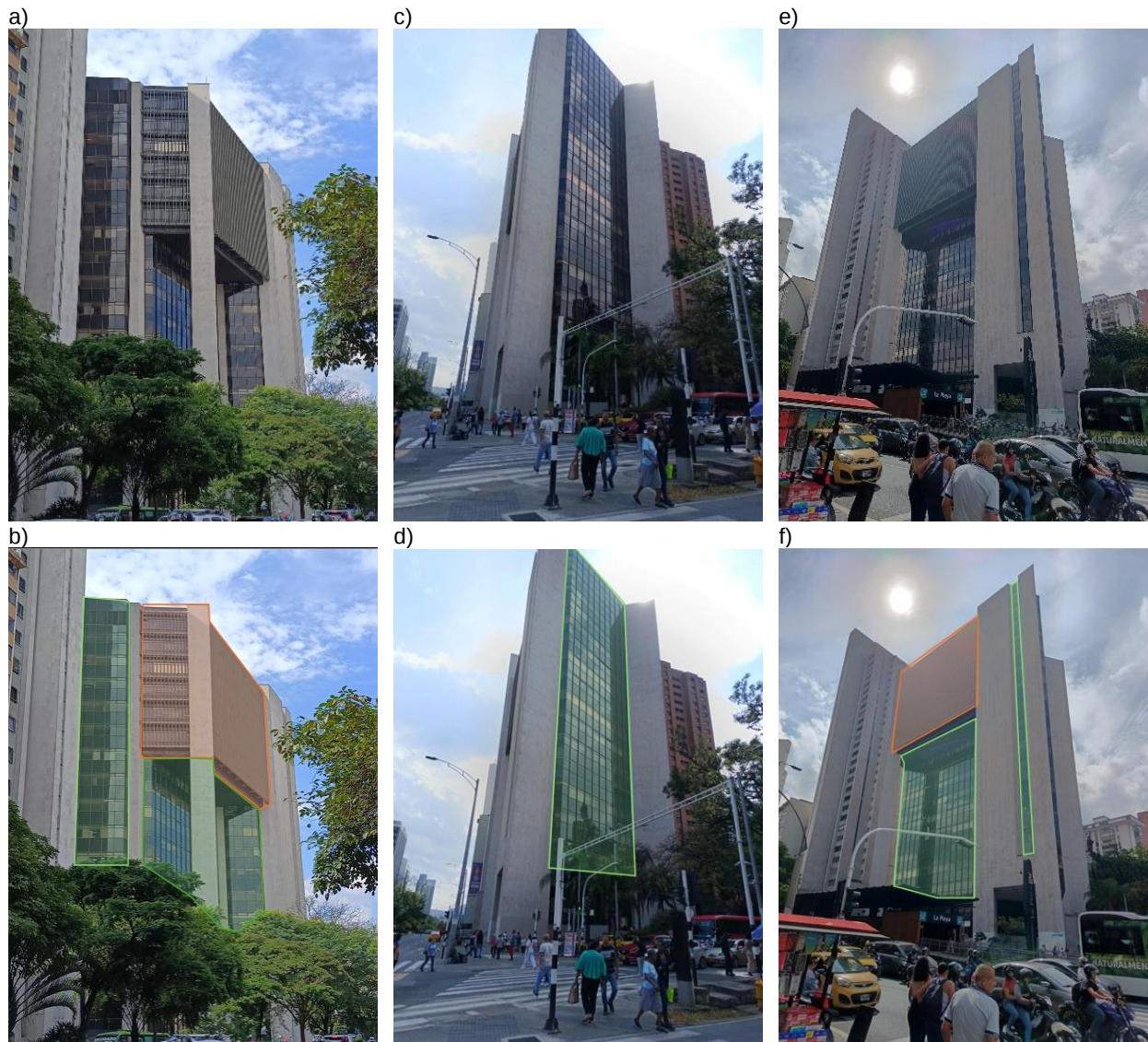
Figura 45. Identificación de fachadas. a) y b) Fachada norte. c) y d) Fachada sur. e) y f) Fachada oeste.
