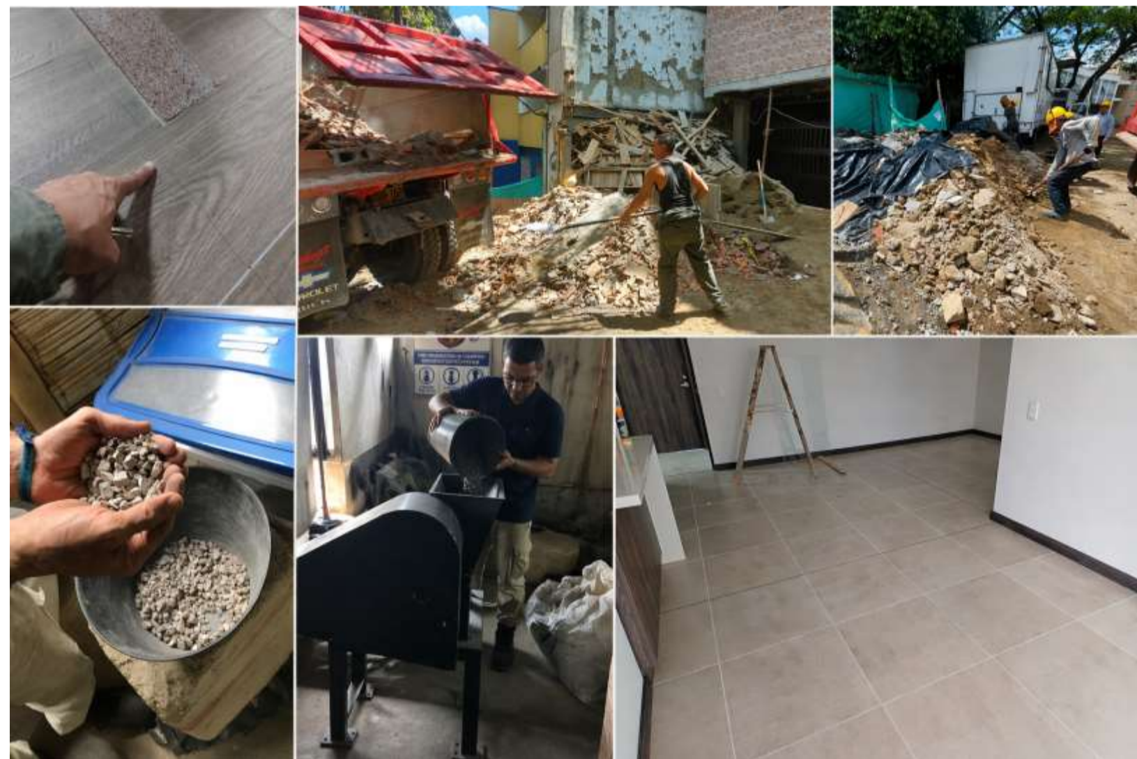
Figura 1: Residuos de demolición
