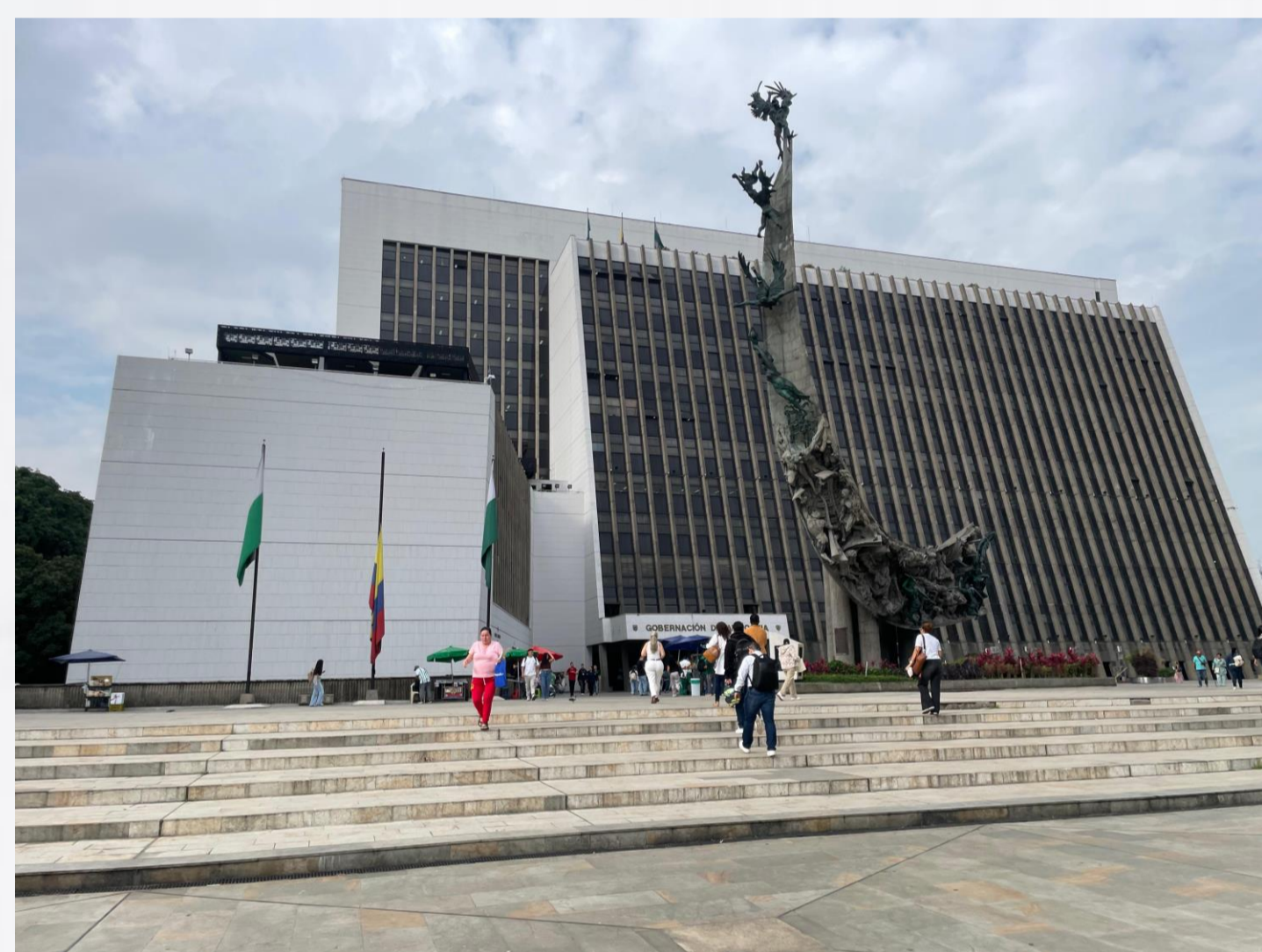
Figura 1. Centro administrativo alpujarra.
