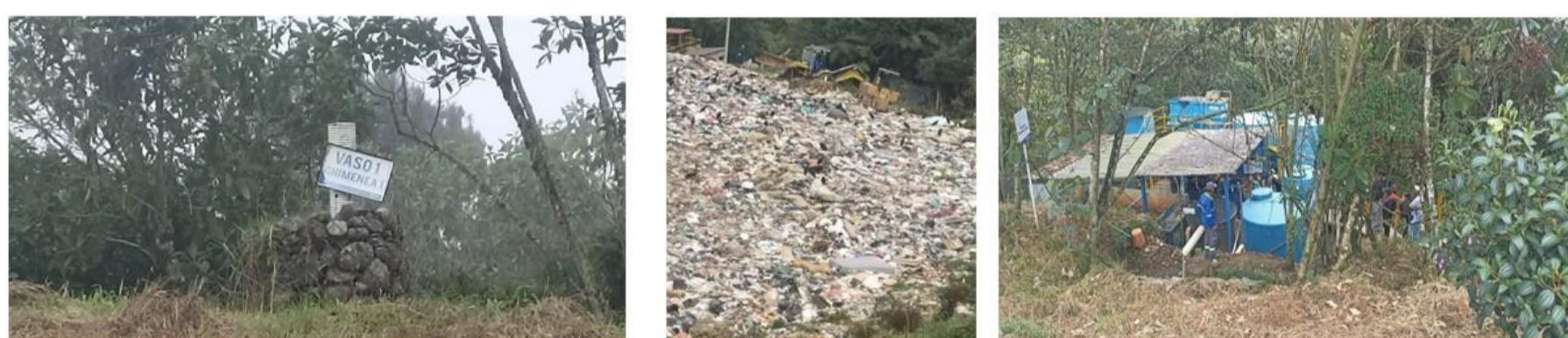
CHIMENEA DE VASO CLAUSURADO
