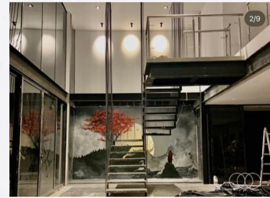
Fotografía 3: Estructura metálica en vivienda.
