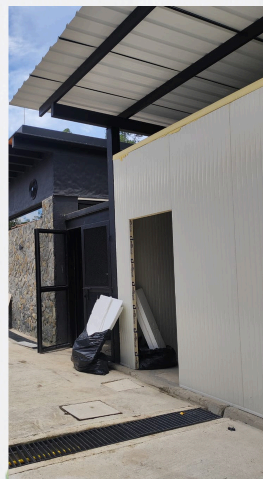
Visita de campo - montaje cava de maduración (El Retiro, Ant)
