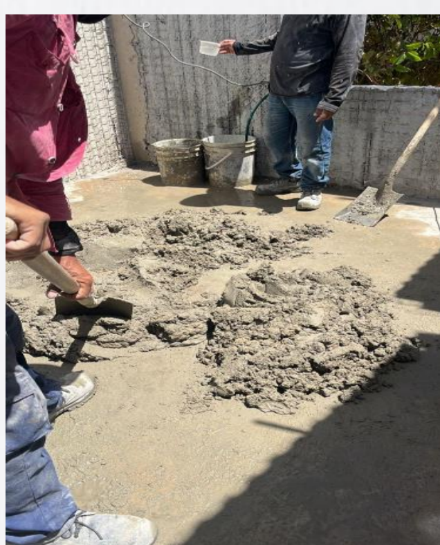
Preparación de mortero para revoque Fuente: Elaboración propia
