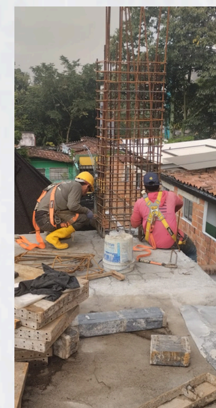
Imagen 4. Obra Livvo Living Fuente: Fotografía propia
