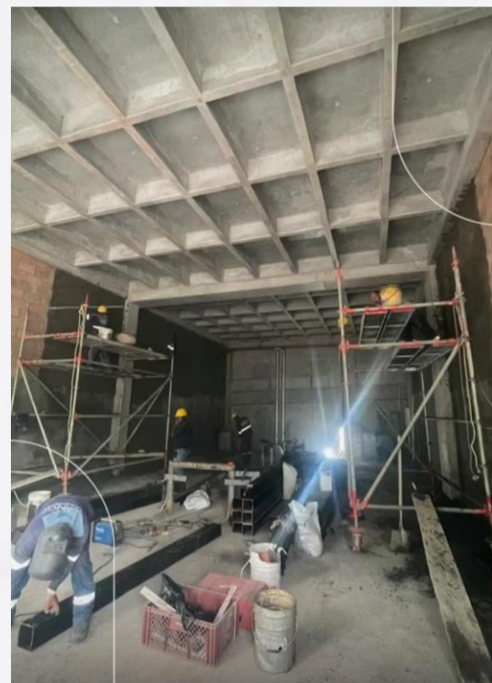
Fotografía 1: Losa reticular en hormigón.
