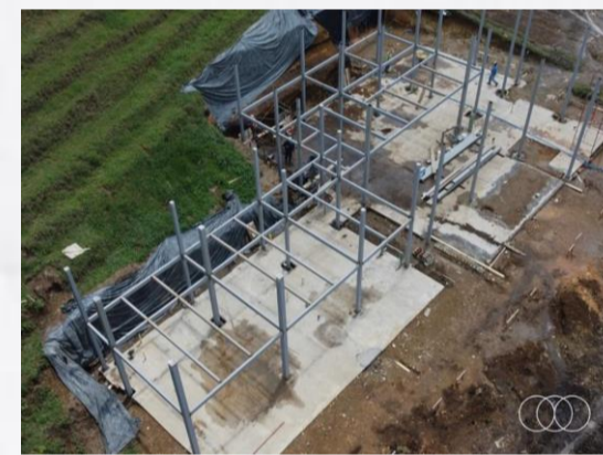
Fotografía 4: Estructura metálica en proyecto comercial.
