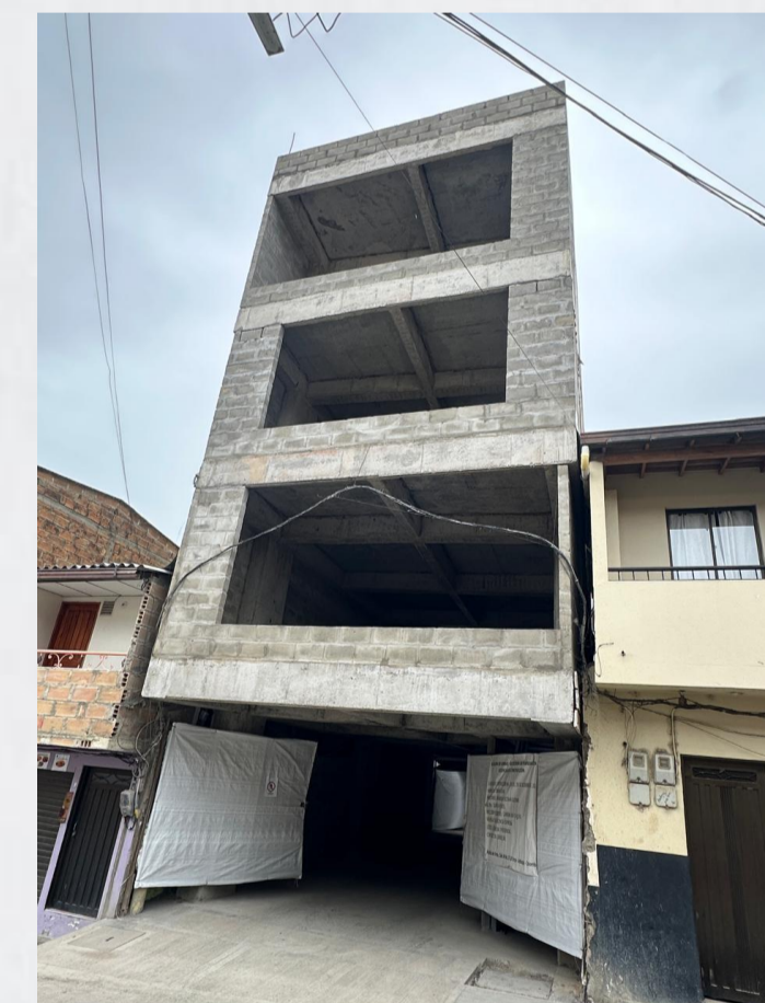
Fotografía 16: Ejecución de obra.
