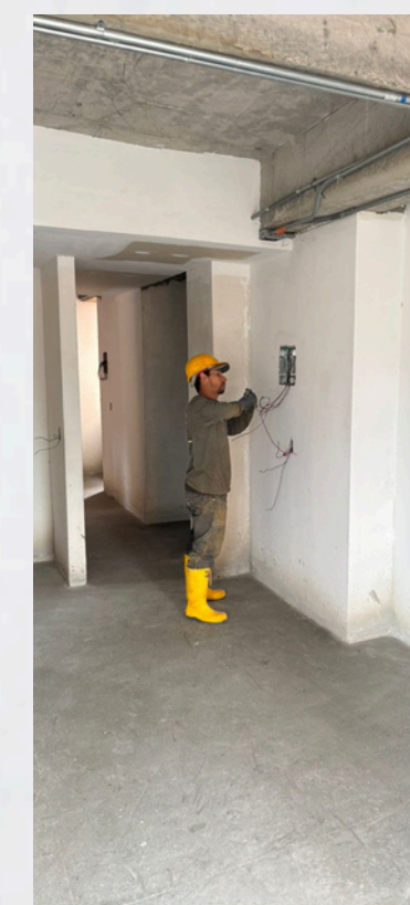
Imagen 5. Obra Be/Side Fuente: Fotografía propia
