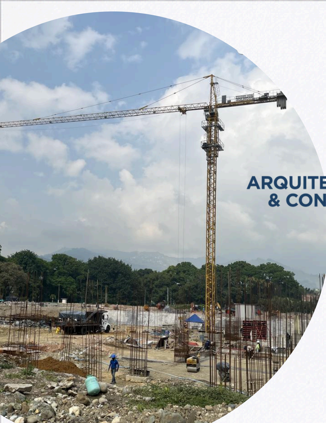
Figura 1. Ejecución de obra.
