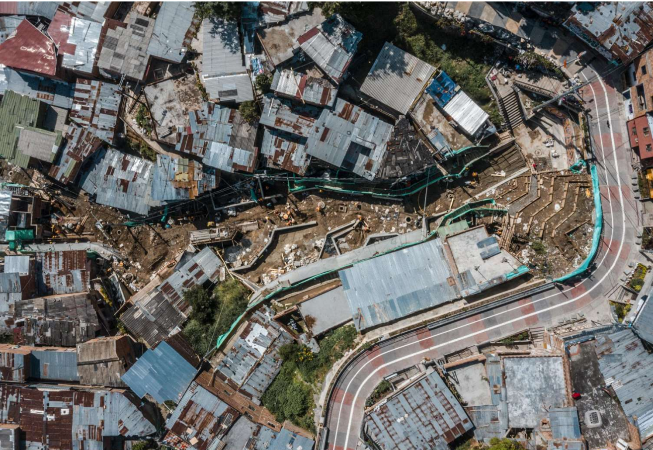
Ejecución obra proyecto Sendero de conexión 2_Empresa de Desarrollo Urbano - EDU
