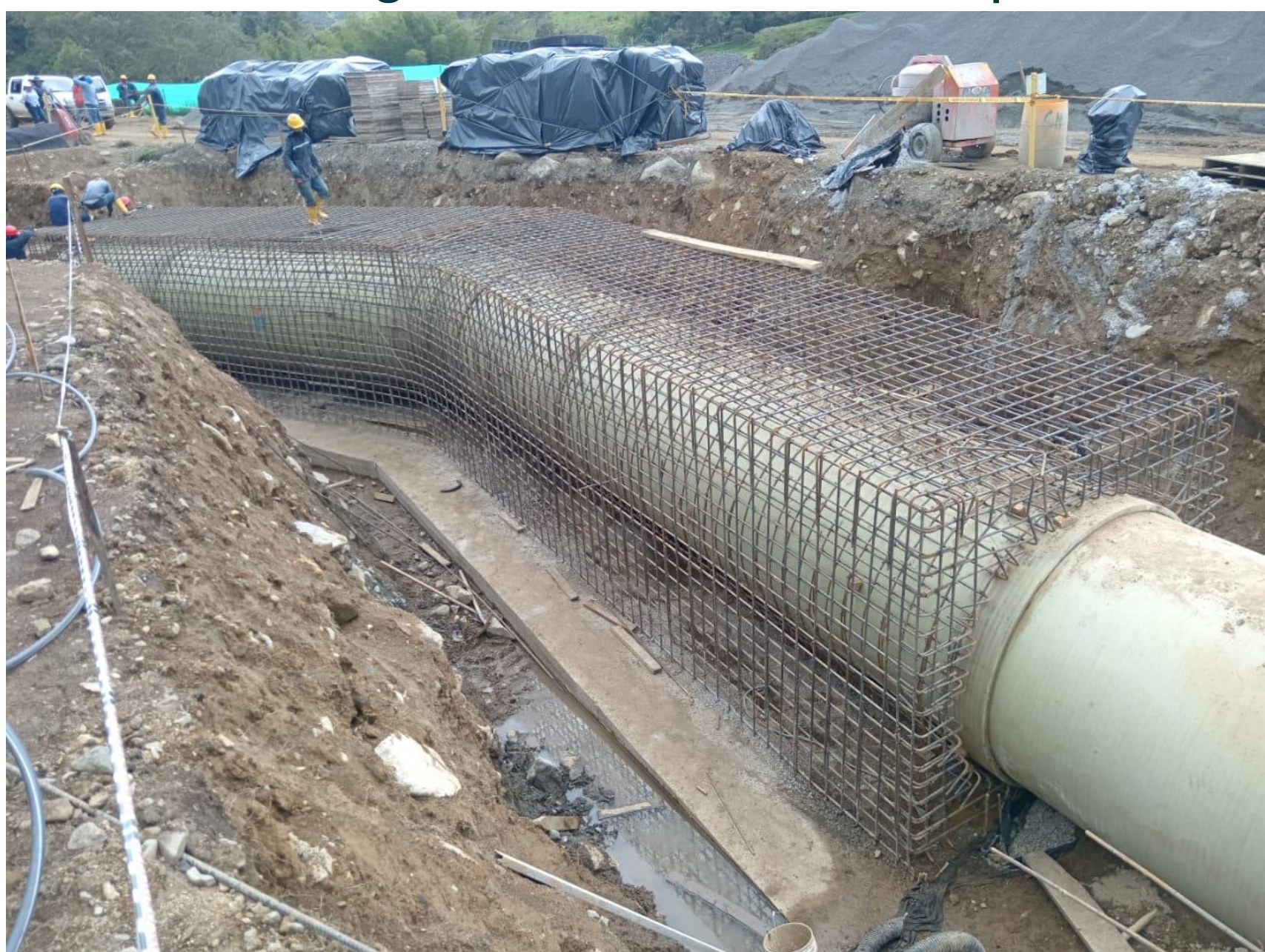
(Acero de Refuerzo Bloque de Anclaje en la Conducción a Presión – Fuente Propia)
