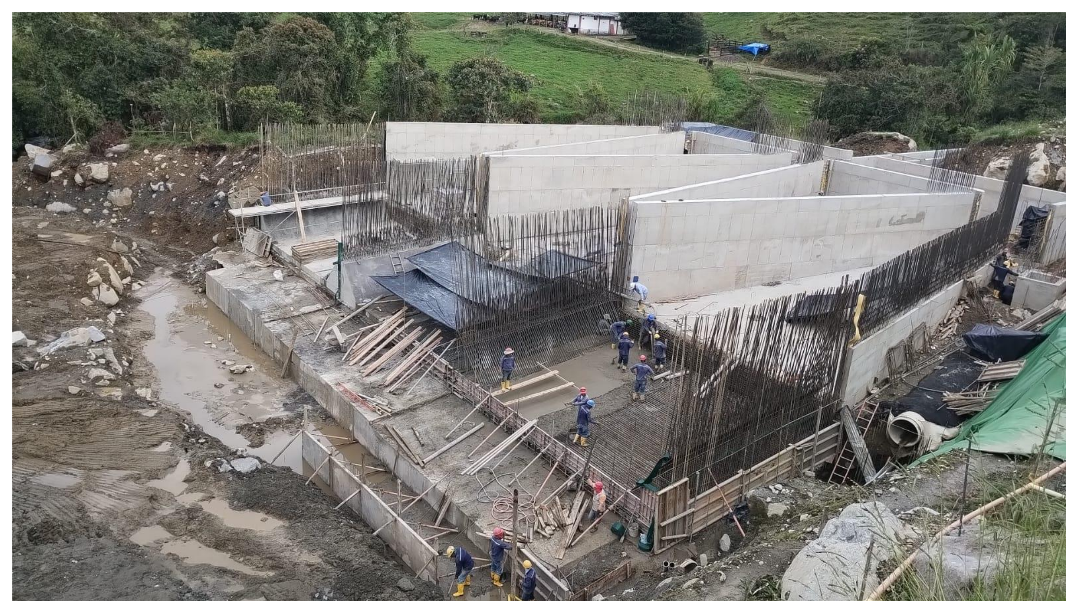
(Construcción Tanque Desarenador PCH El Remanso – Fuente Propia)
