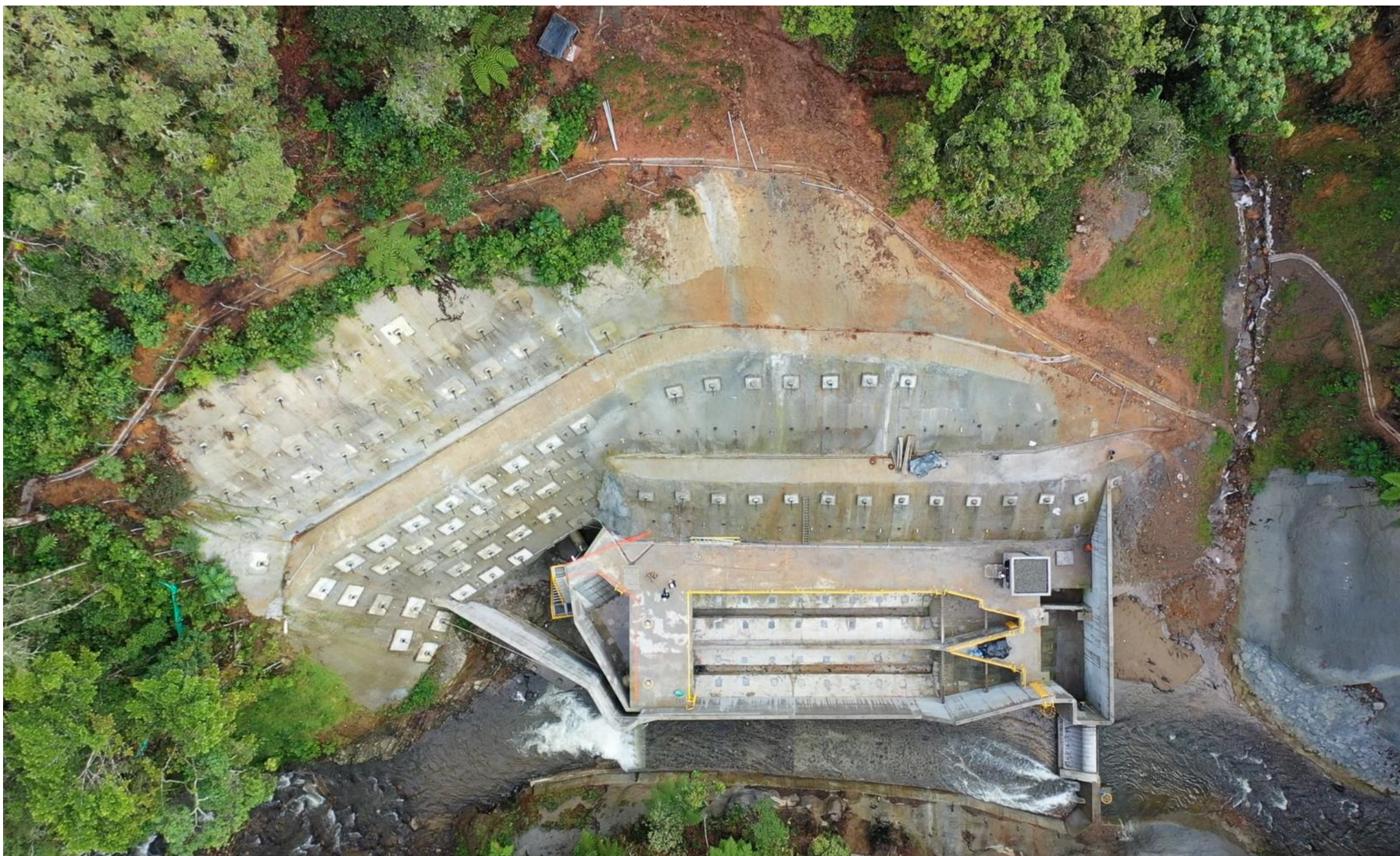
(Captación PCH La Chorrera – Fuente Propia)
