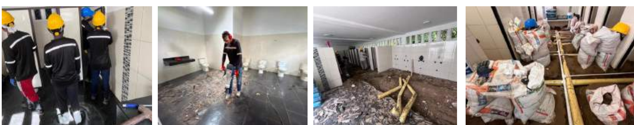
Imágenes 4-7: Demolición de piso, retiro e instalación tubería nueva
