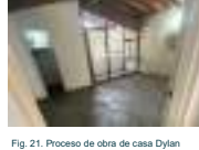
Fig. 21. Proceso de obra de casa Dylan
