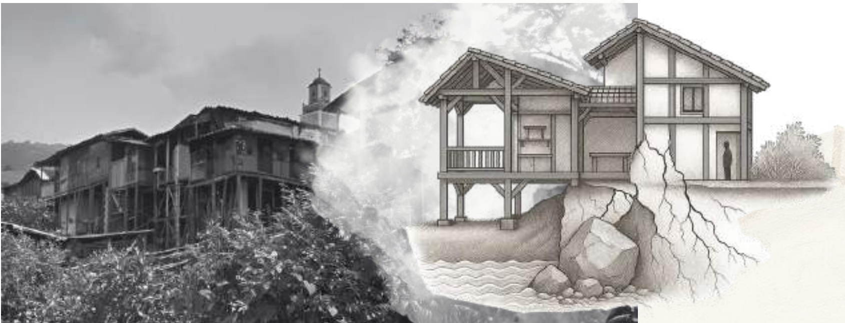
Figura 1. Vivienda rural autogestionada comprometida por riesgo. Buenos Aires, Andes, Antioquia. Fuente. Elaboración por inteligencia artificial (OpenAI, mayo de 2025).
