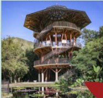
Mirador de cuatro pisos diseñado por el reconocido arquitecto colombiano Simón Vélez. Esta estructura, construida con guadua, madera de Fasciáplus pellica, concreto y acero, permite a los visitantes observar el abed arboreo en sus distintas alturas, ofreciendo una experiencia única de conexión con la naturaleza.
