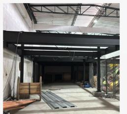
Imagen 6: Bodega – Estructura metálica, columnas y vigas
