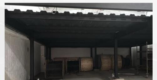
Imagen 7: Estructura metálica - Metaldeck
