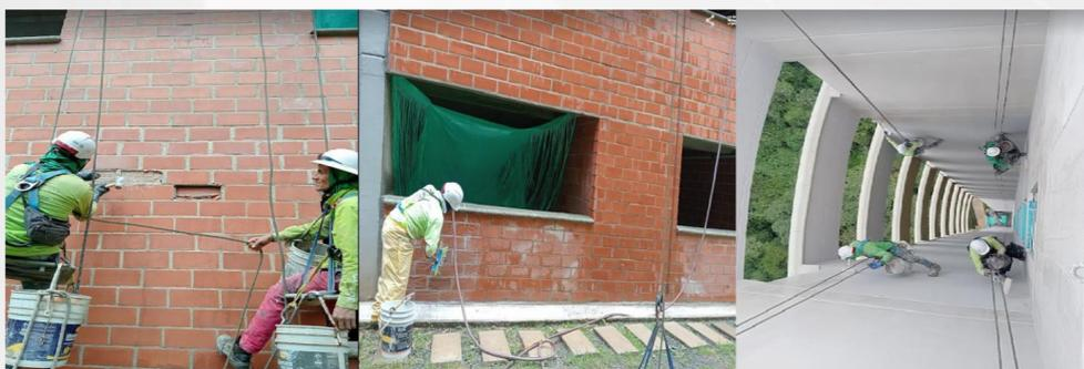
Imagen 2. Cambio de chapas, lavado de muros, aplicación de pintura.
