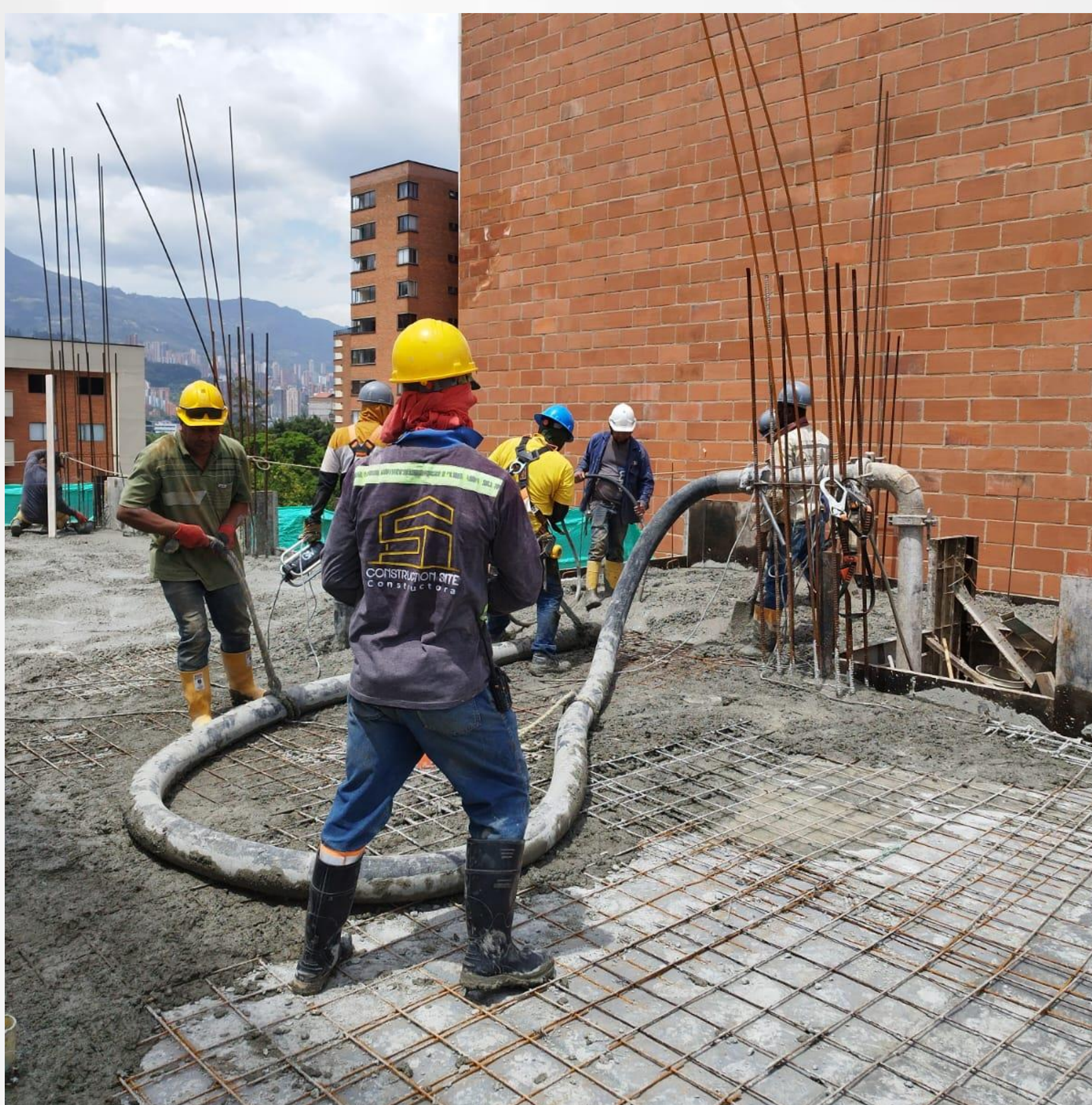
Imagen: Registro fotográfico de obra.
