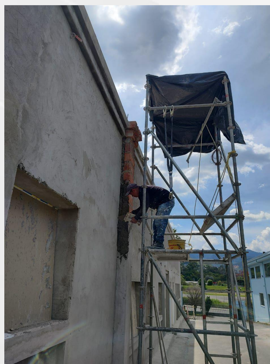
Fig. 2. Fachada Codiscos Fuente: Elaboración propia
