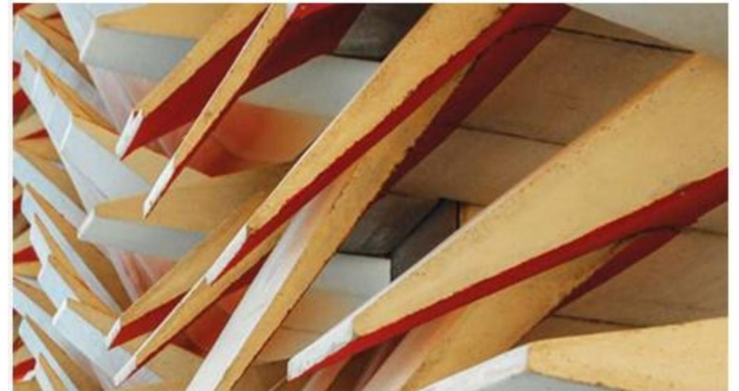
➤ Elemento prefabricado de concreto de alta resistencia, de la fachada oriental.
