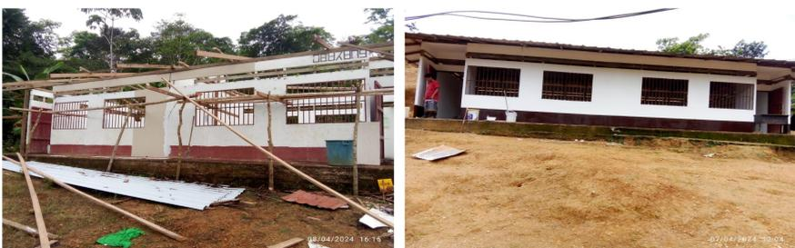
Imagen 1 y 2. mantenimiento de techo y aplicación de pintura
