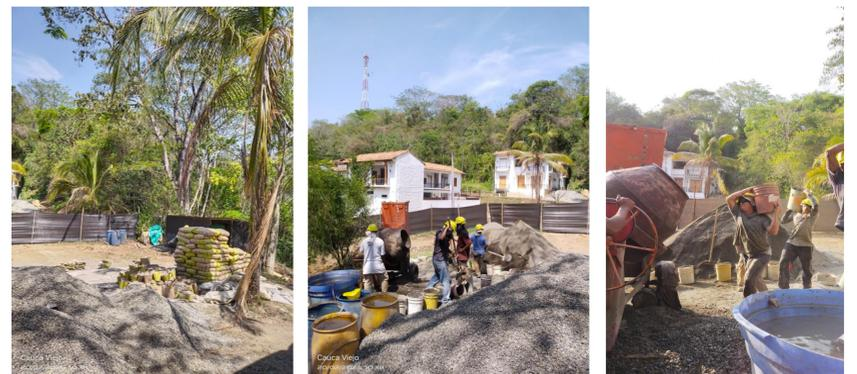
Figura 3. Preparación en obra de concretos sostenibles.
