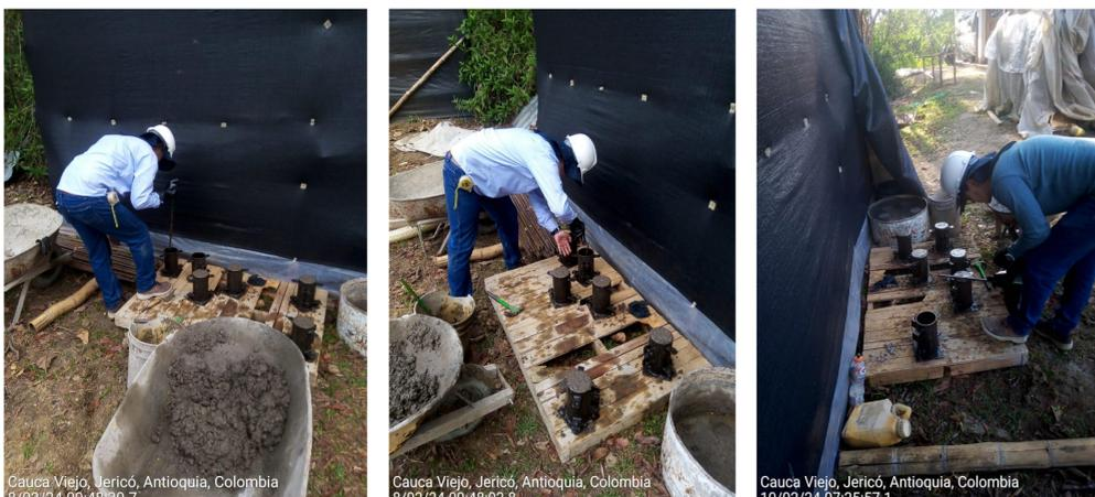
Figura 2. Control en obra de los concretos sostenibles.
