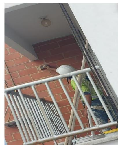
Imagen 7: intervención de balcones con hidrofugo Fuente: propia.
