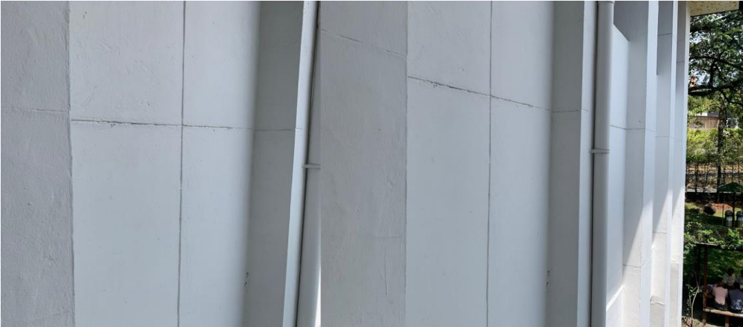
Revestimiento de muro - Bloque Patrimonial Colmayor
