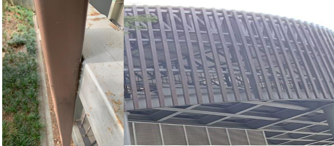
Soldadura elementos metálicos - Bloque de Bienestar Colmayor
