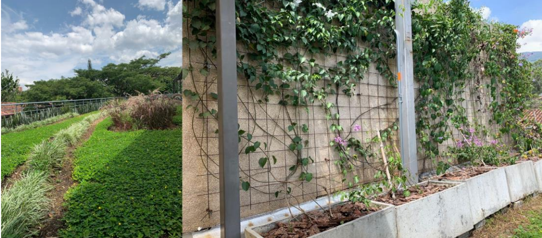
Cubierta verde - Bloque académico Colmayor
