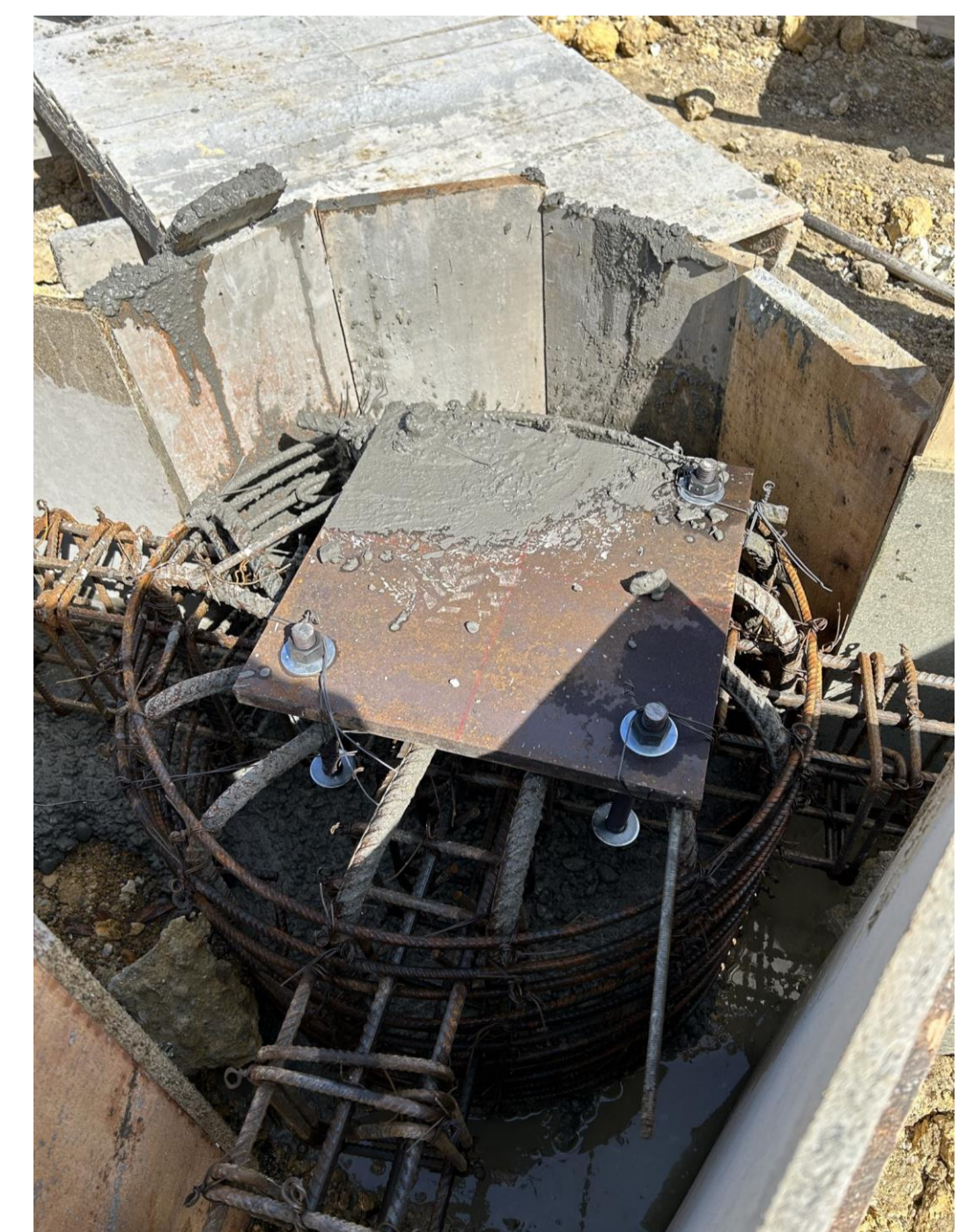
Imagen 6. pilote para muros de contención. Fuente: Propia
