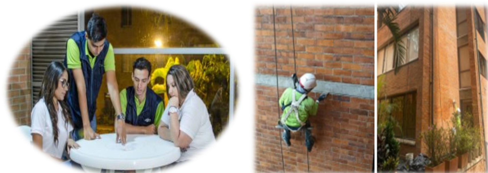
Imagen 1 y 2. aplicación de pintura
