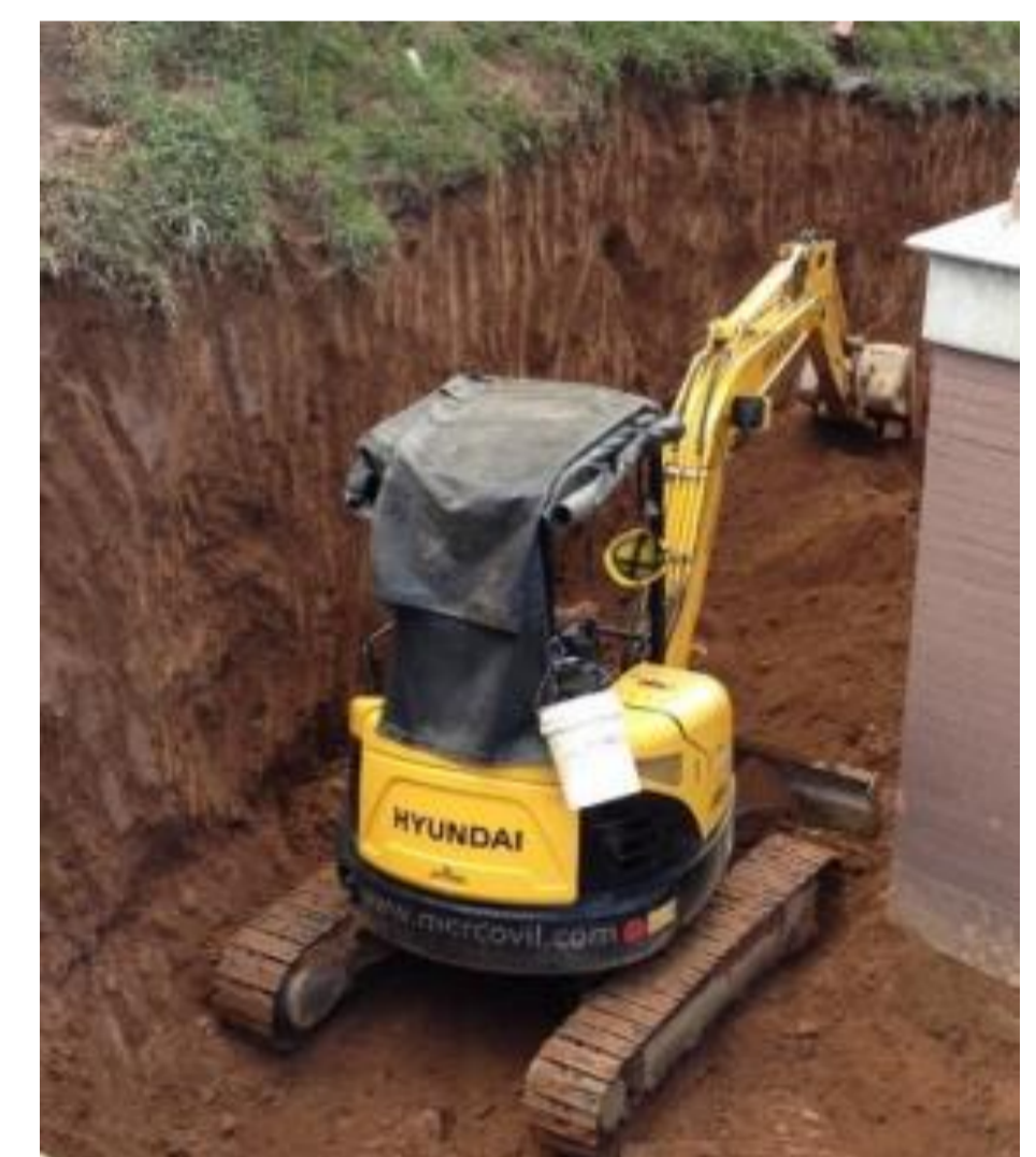
Imagen 5. . Excavación para construcción de muro de contención.. Fuente: Propia
