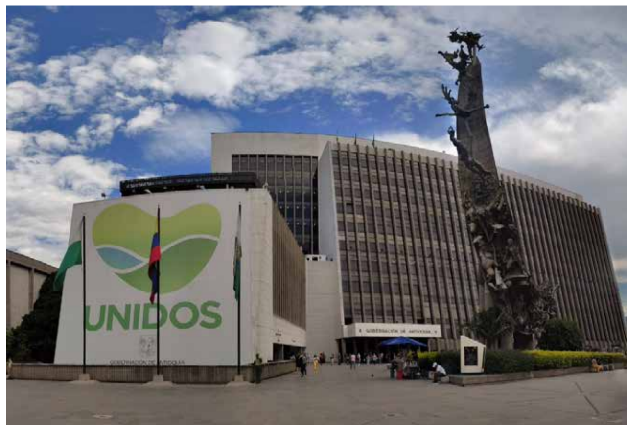
Ilustración 1. Edificio Gobernación de Antioquia Fuente: https://acortar.link/tX3QTR
