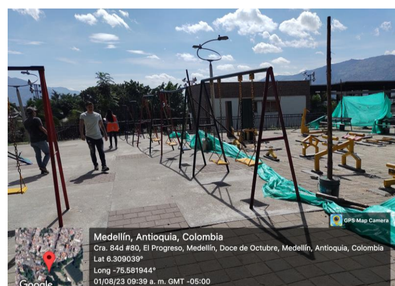
Figura 6. EPEE Cancha Los Lotes, Comuna 6. Fotografía Propia.
