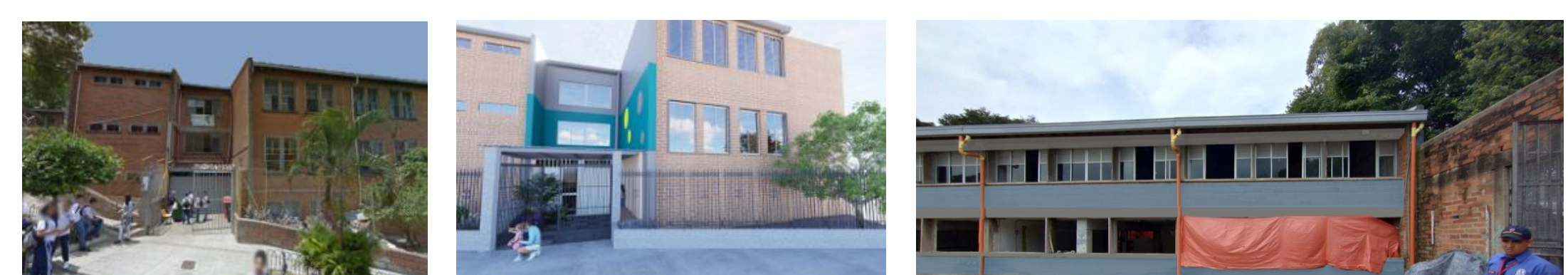
Imagen # 6-7.Adecuación Fachada I.E. Ciro Mendia.
