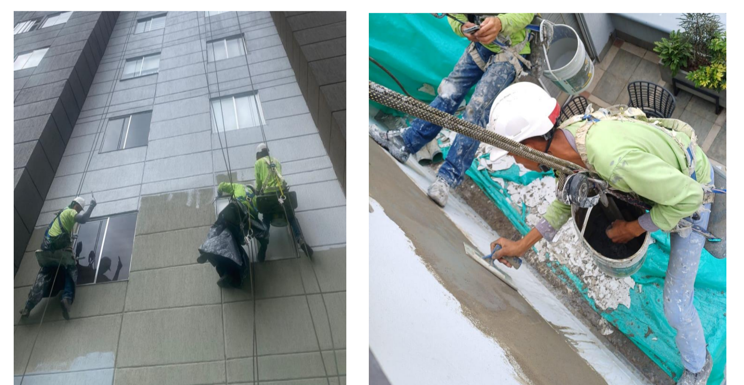
Imagen 6,7,8,9 aplicación de pintura y resanes Fuente: Elaboración propia
