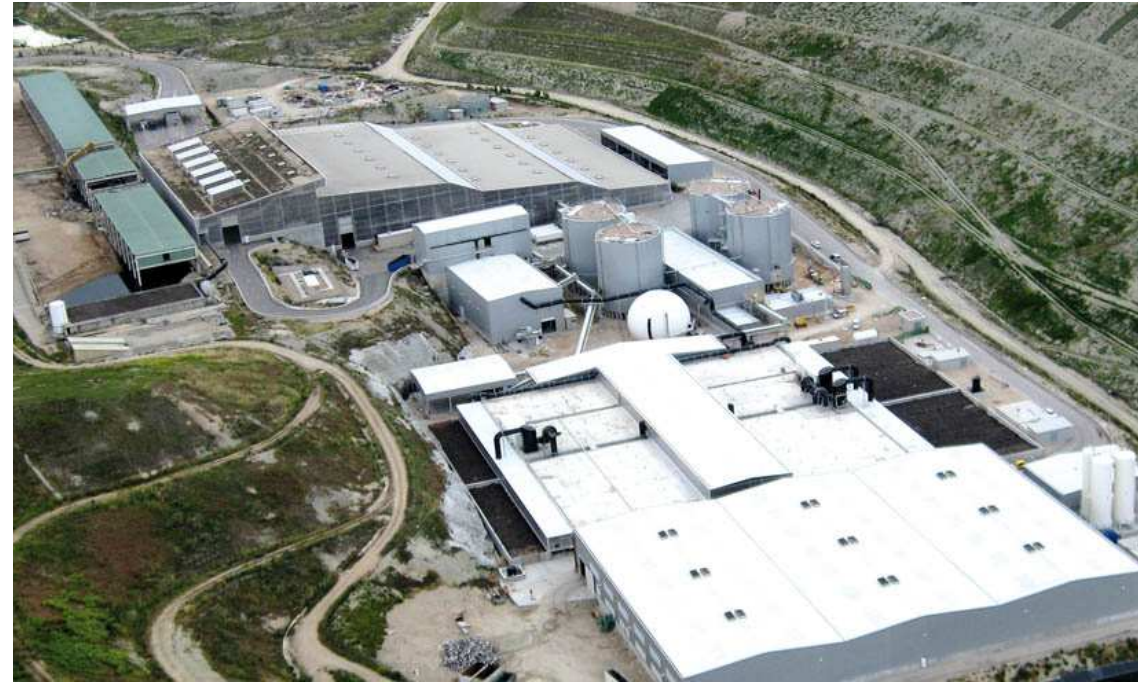
Planta de biometanización Parque Tecnológico de Valdemingómez (PTV). Fuente: https://rinconeducativo.org/es/visitas/centro-rsu-pt-valdemingomez/
