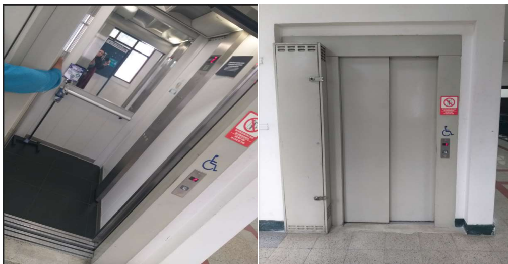
Fuente: fotografía zona administrativa –bloque fundacional ascensor. Elaboró: profesionales de la Oficina de Evaluación y Control
