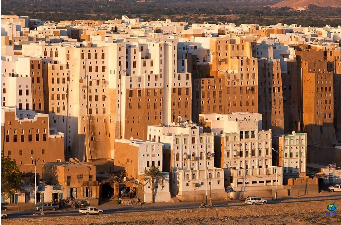
Shibam, Yemen edificaciones construidas desde Año 1530. En adobe a mano.
