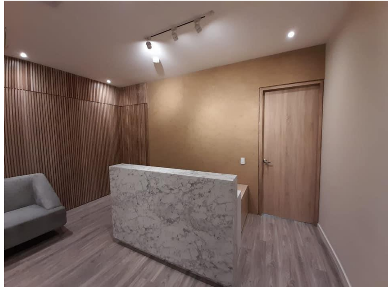
Spa Equilibrio. Torre Inexmoda, Poblado, Medellín. 2021 Revoques y pintura en tierra Indise Arquitectura + Johan Marin Asesoría técnica
