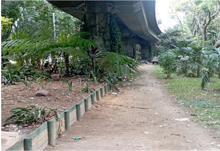
1. Columnas metro (estadio a floresta) (fuente propia)
