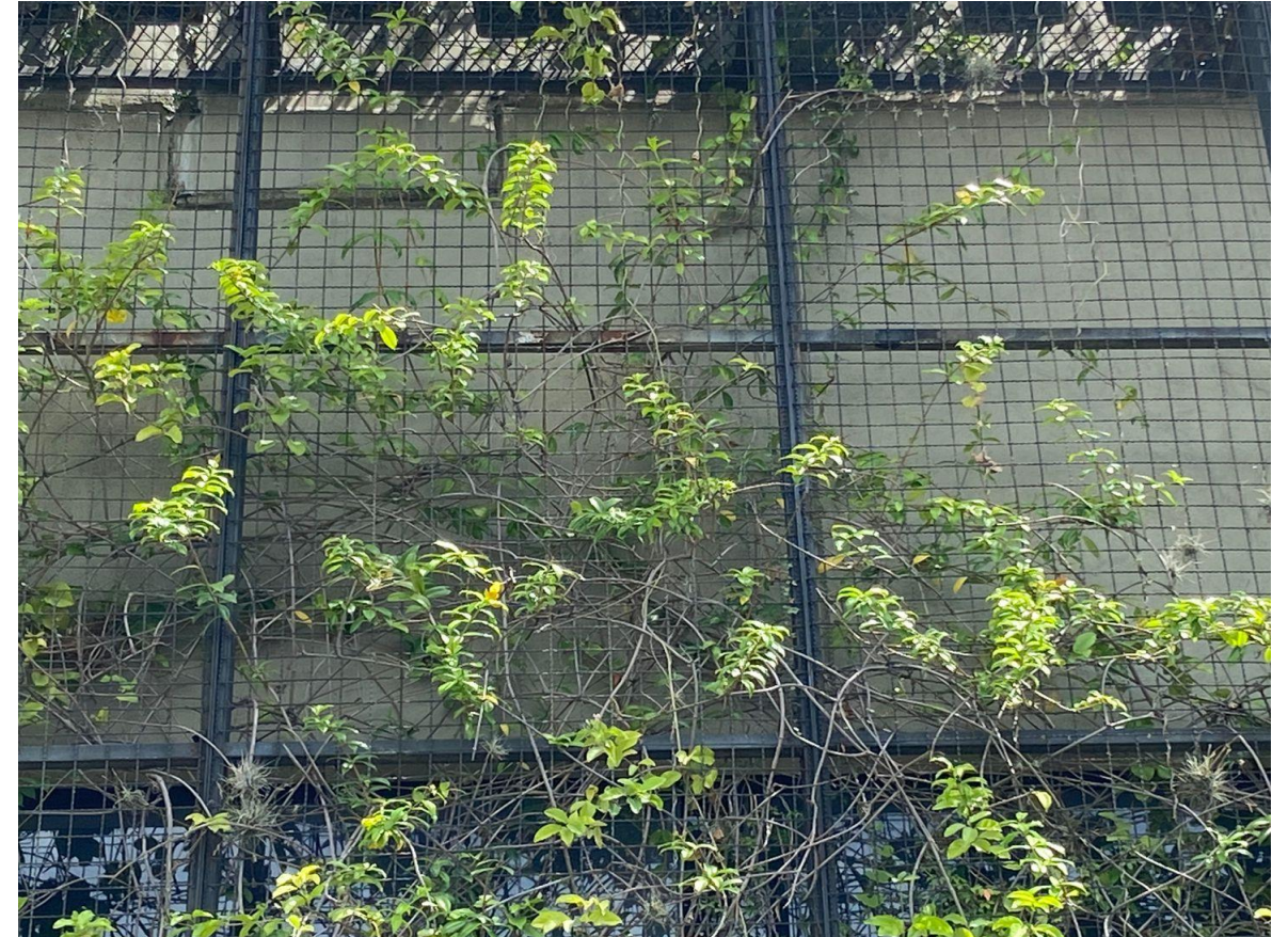
7. Edificio térmico epm (fuente propia )
