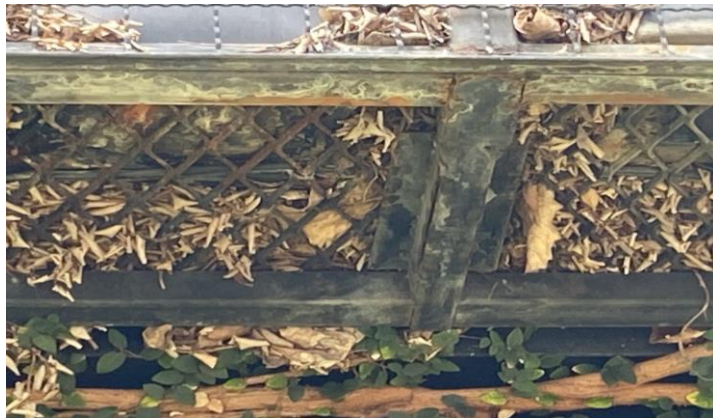
20. Edificio térmico EPM (fuente propia)
