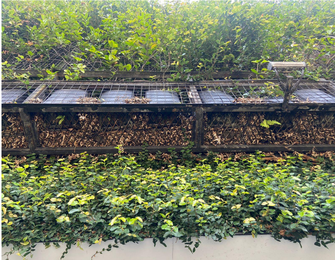
6. Edificio térmico epm (fuente propia )
