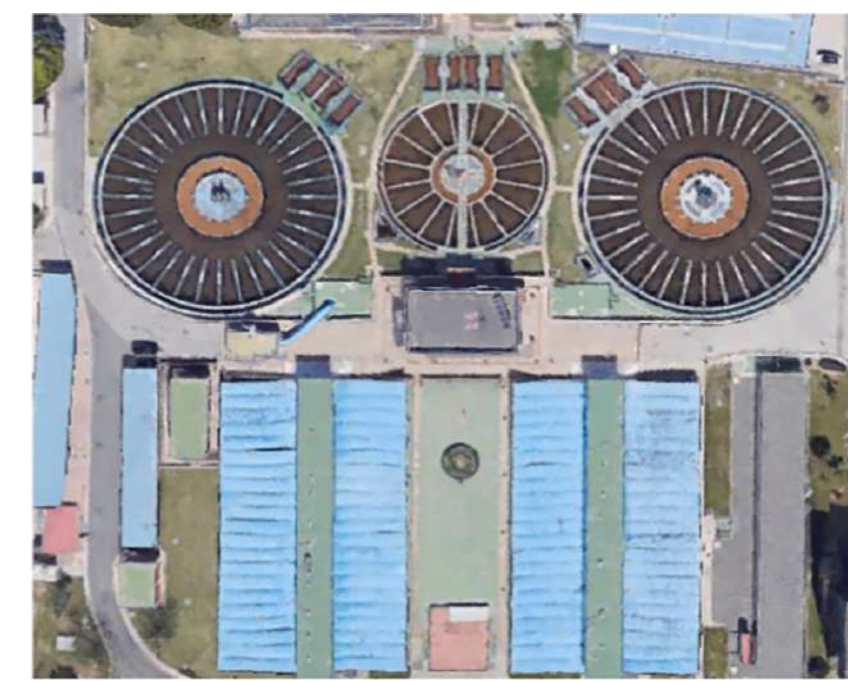
Fig. 3. Fotografía aérea de la ETAP (Atabal).
