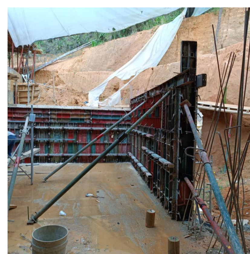
Modulación de equipo, formaletas para muro pantalla
