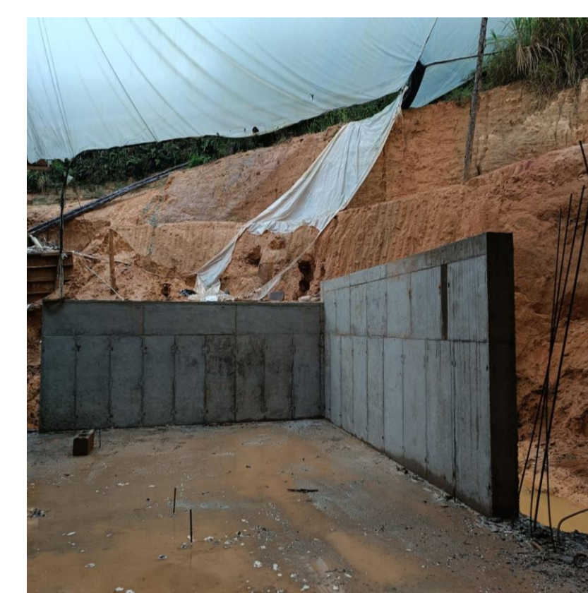
Muro pantalla vaciado
