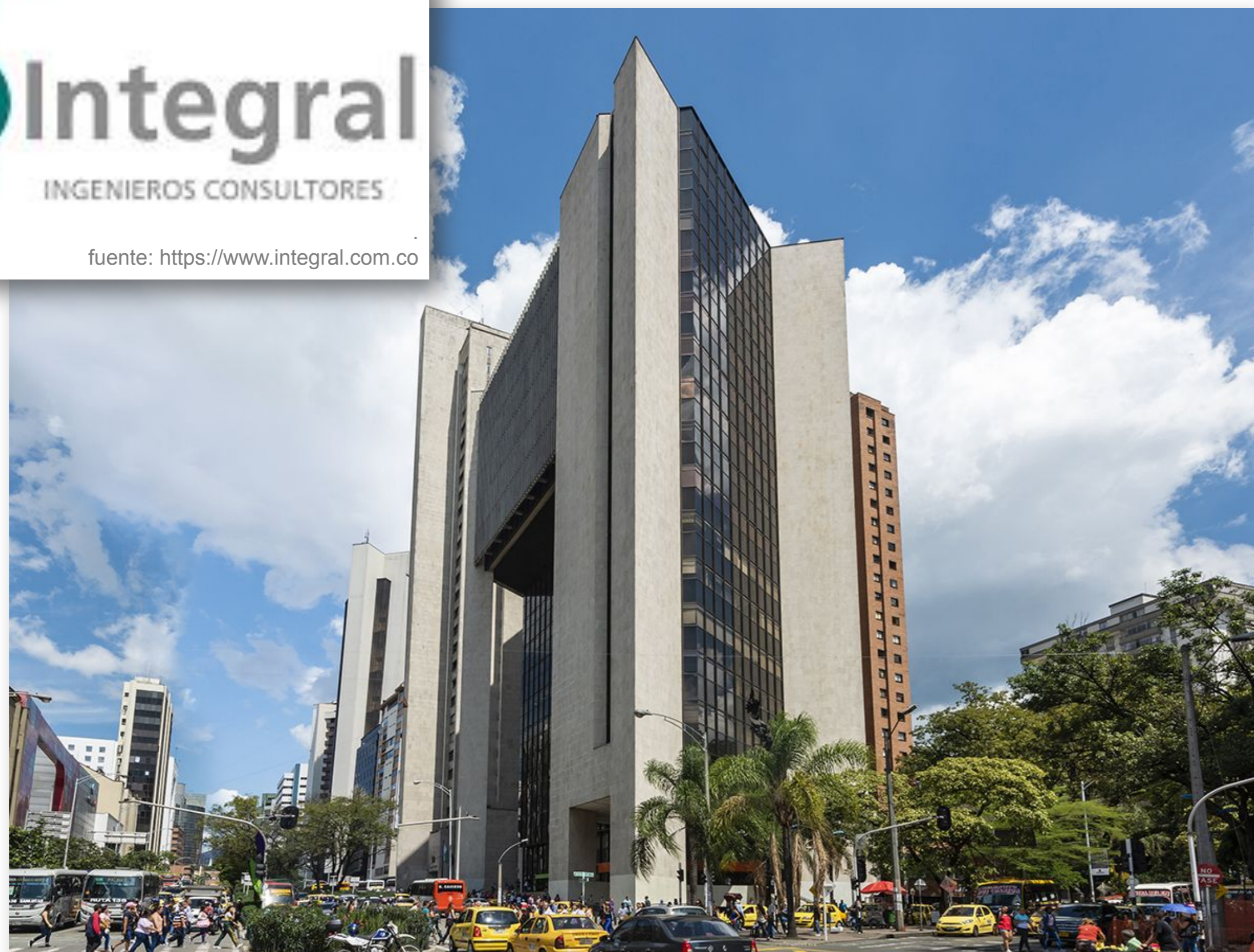
Figura 2: Edificio principal de Integral S.A. en Medellín
