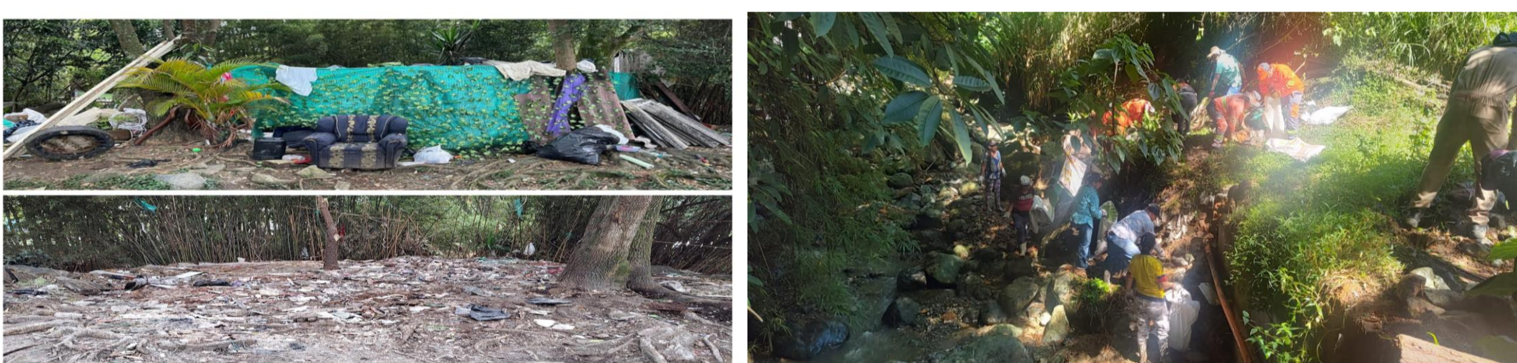
1. Antes y después de intervenir un punto crítico cerca a estación del metro 2. Intervención a la quebrada la picacha acumulación de voluminosos y RCD
