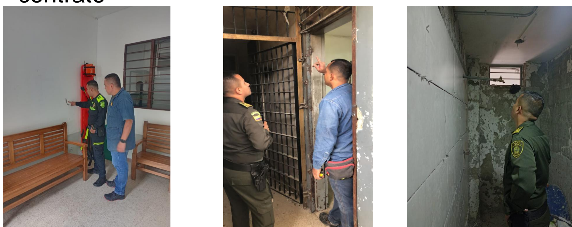
Figuras 2,3 y 4: Visitas técnicas de inspección a Estaciones de Policía Manrique
