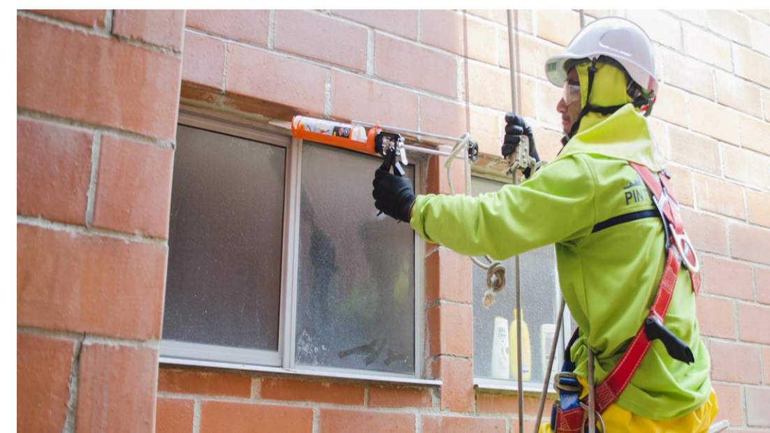
3. Aplicación Silicona. (Fuente: Pintufachadas S.A.S)
