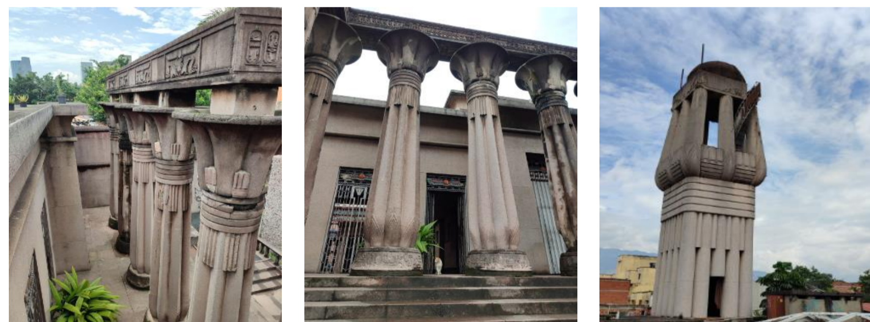
Figura 2. Fachada Palacio Egipcio (desde otra perspectiva). Fuente propia.
