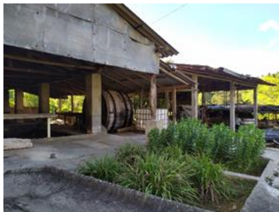
Imagen 135 Curtiembre Fuente propia, 2021.
