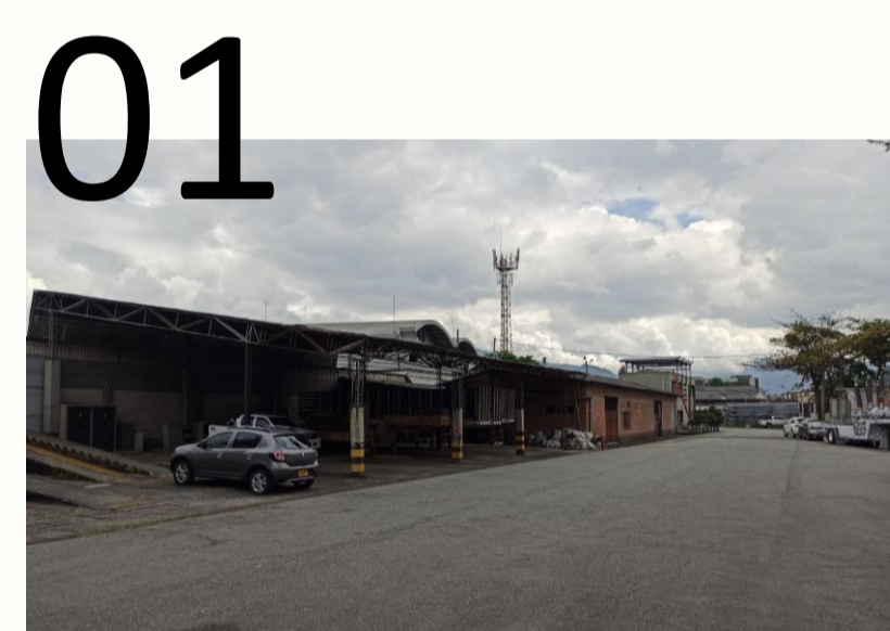
Fotografía 7 J.S (2022, 28 Septiembre). EPM, Centro de servicios metalmecánicos.
