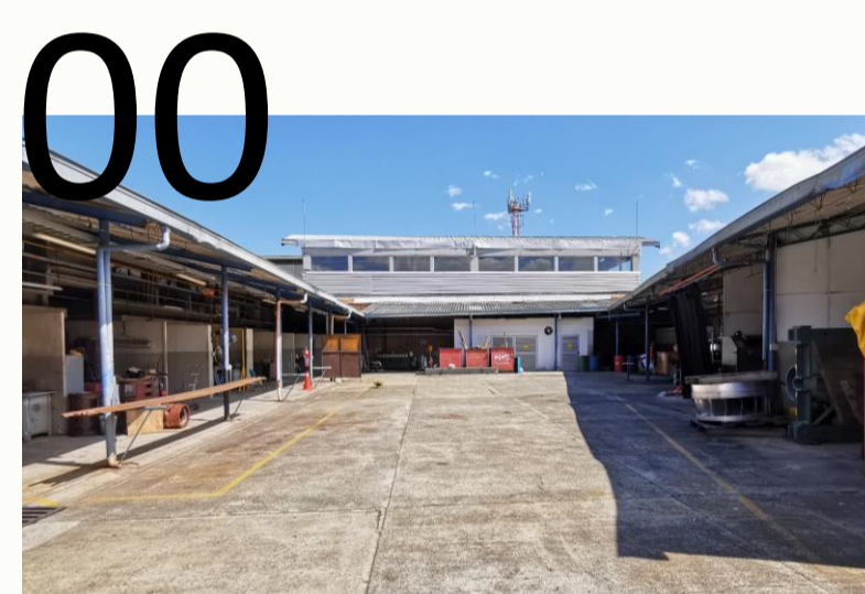
Fotografía 6. J.S (2022, 28 Septiembre). EPM, Centro de servicios metalmecánicos.
