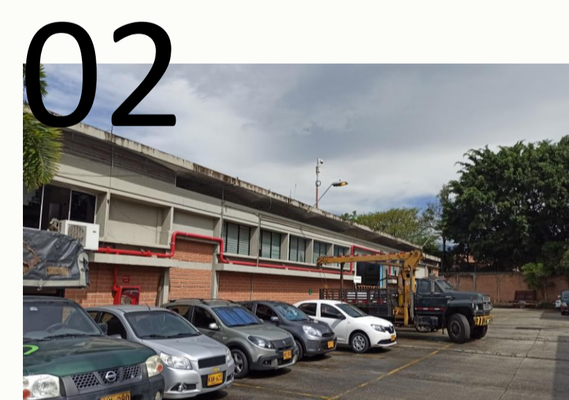
Fotografía 8 J.S (2022, 28 Septiembre). EPM, Centro de servicios metalmecánicos.
