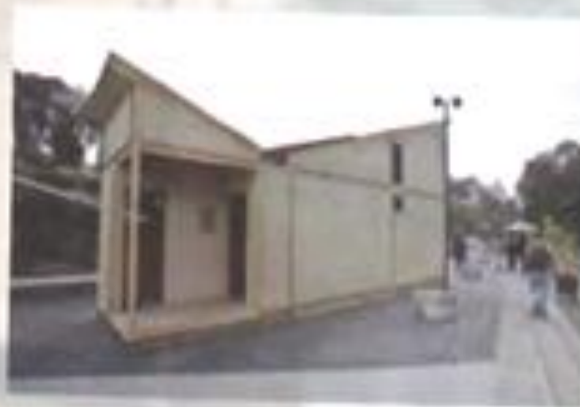
Vivienda temporal de emergencia Foto de archivo: https://www.flickr.com/photos/1234567890/1234567890/ 45533209 - Fuente: arquitectura y diseño 201
