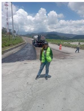
Figura 4. Riego de impregnación en vías
