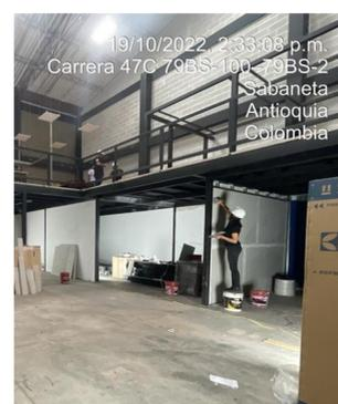
Figura 3. Aplicación de masilla en muros superboard. Fuente propia.
