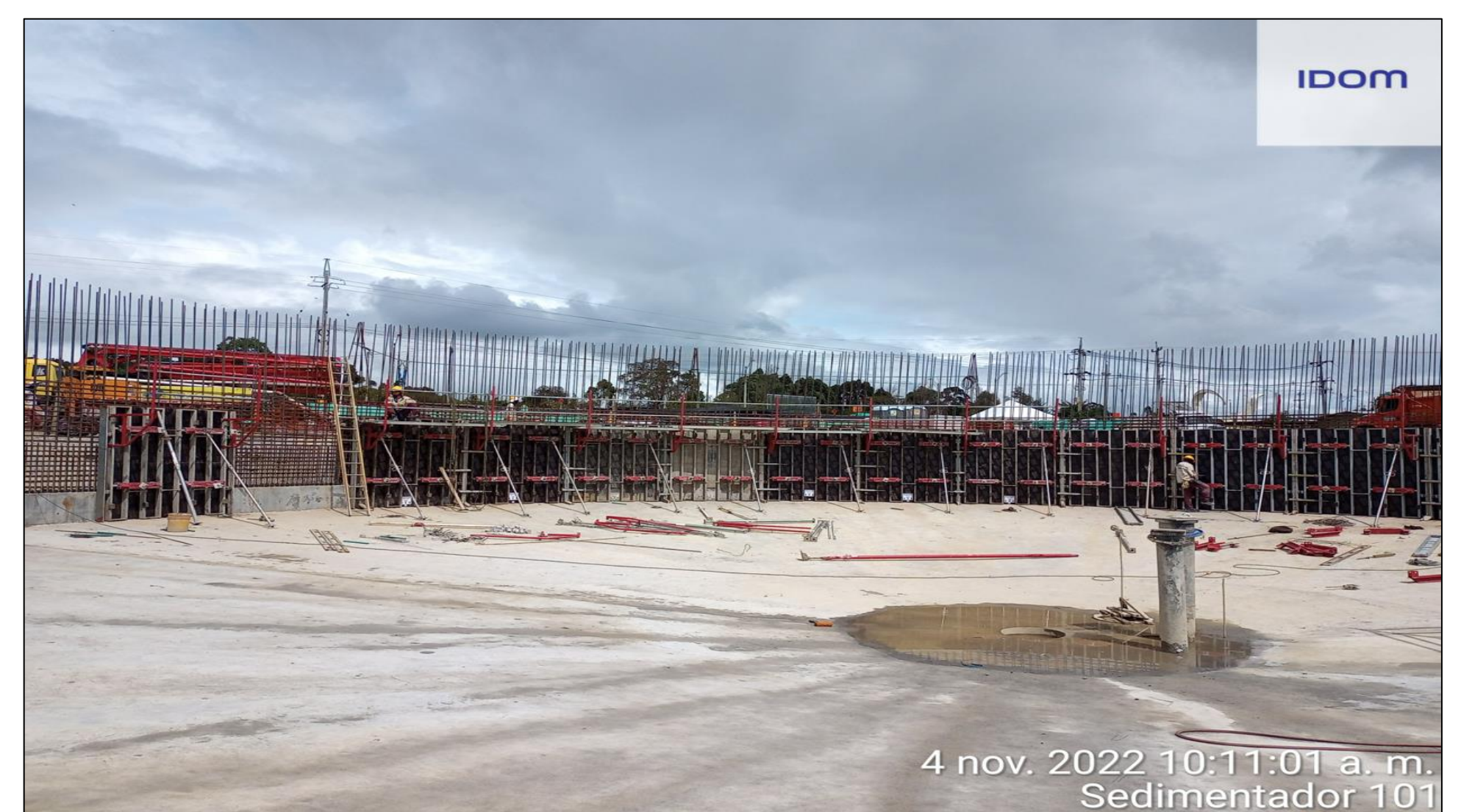
Figura 7 – Instalación de formaleta para muros de medio tanque.
