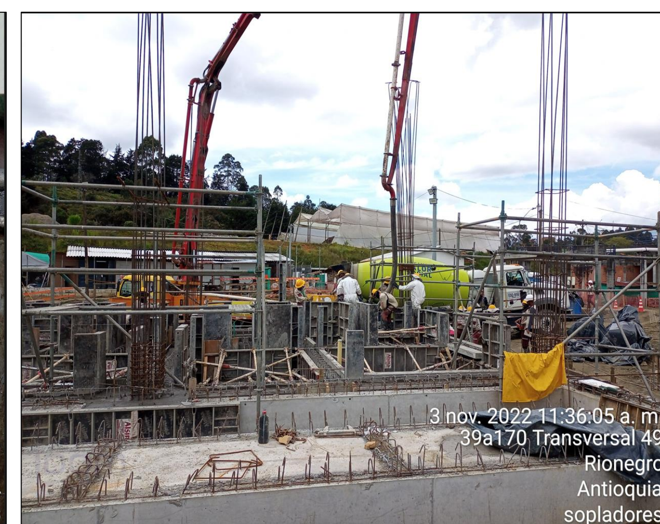
Figura 6 – Fundición de vigas de fundación en edificio de sopladores.
