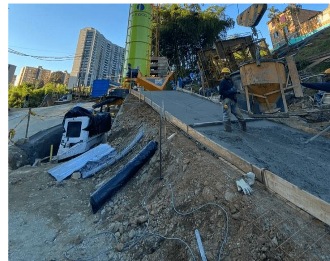
Figura 7: Rampa Bocat. Imagen propia
