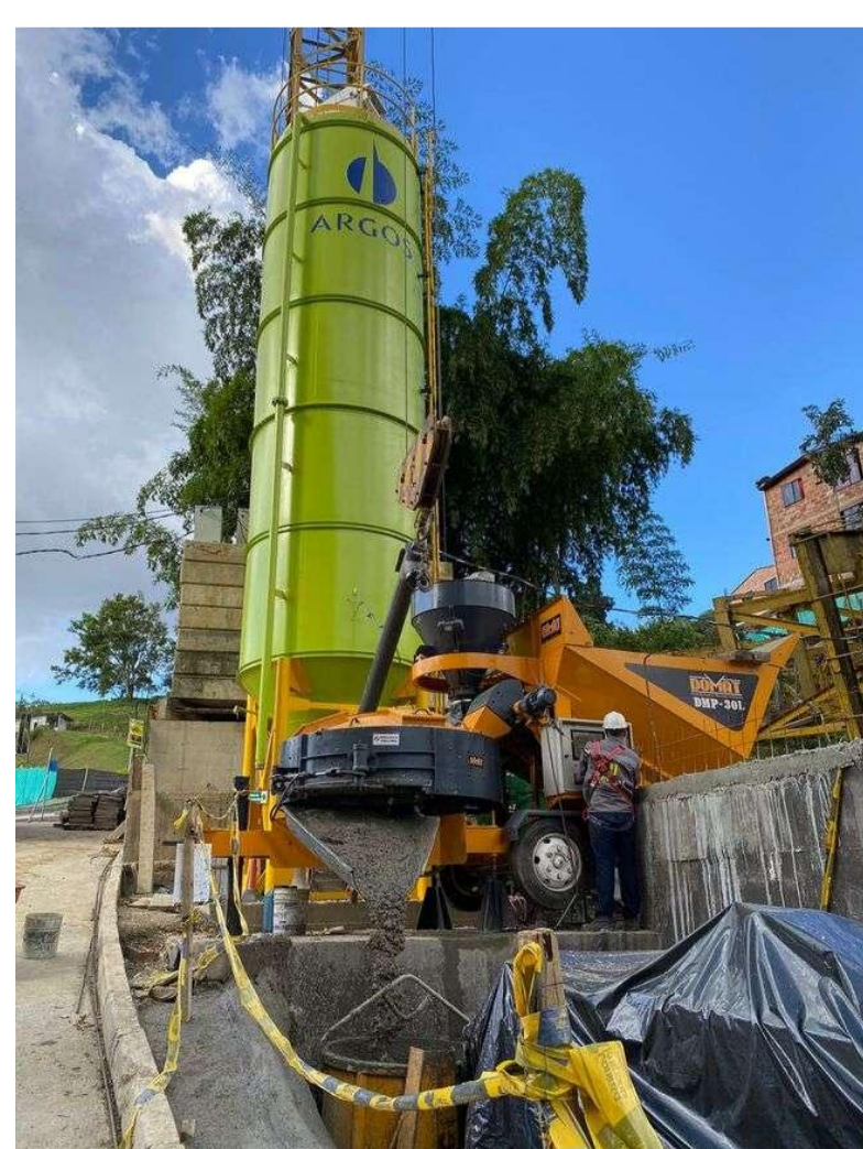
Figura 4: Despacho concreto. Imagen propia
