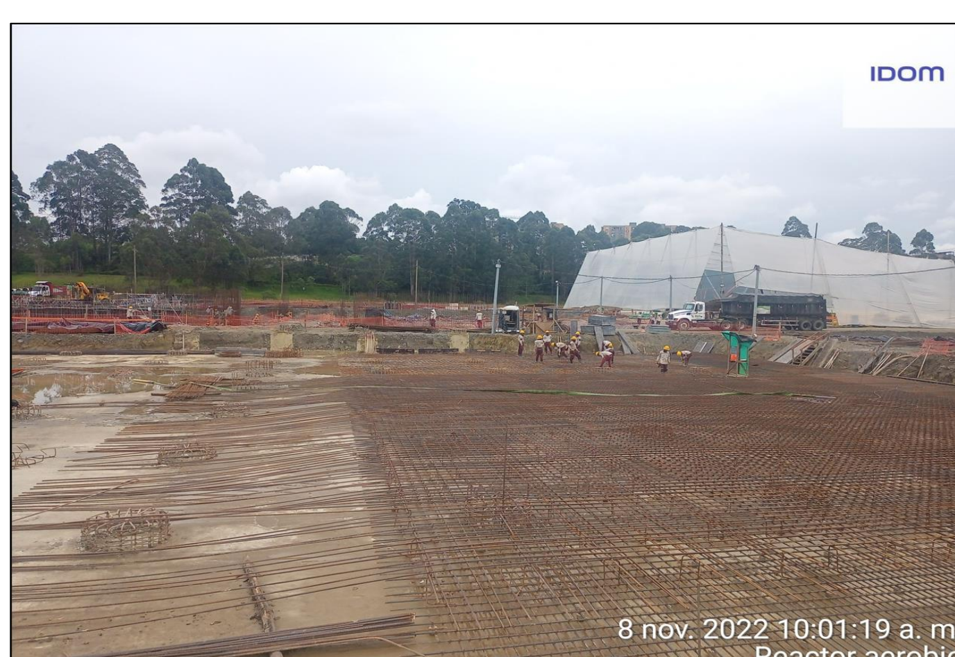
Figura 4 – Instalación de acero de refuerzo de losa en reactor aerobio.
