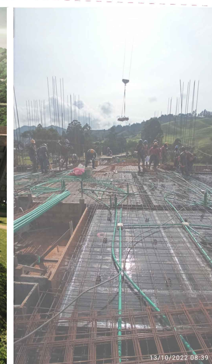
Figura 9. losa torre 6, construcción propia, 2022
