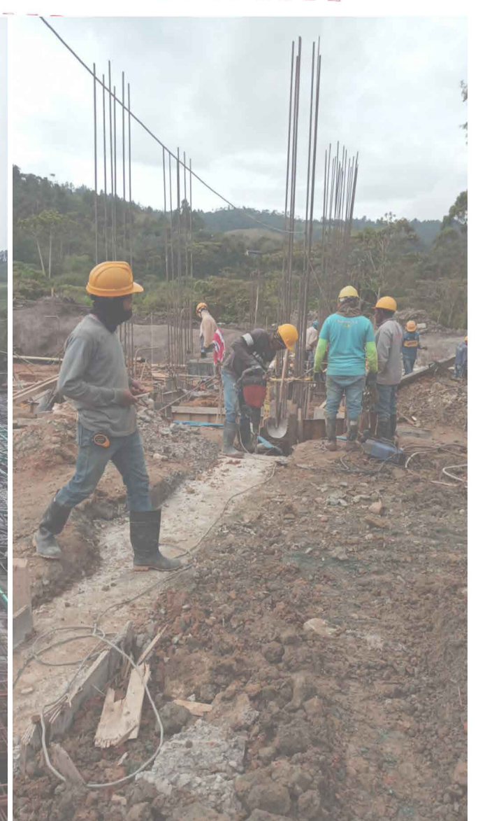
Figura 10. fundación torre 12, construcción propia
