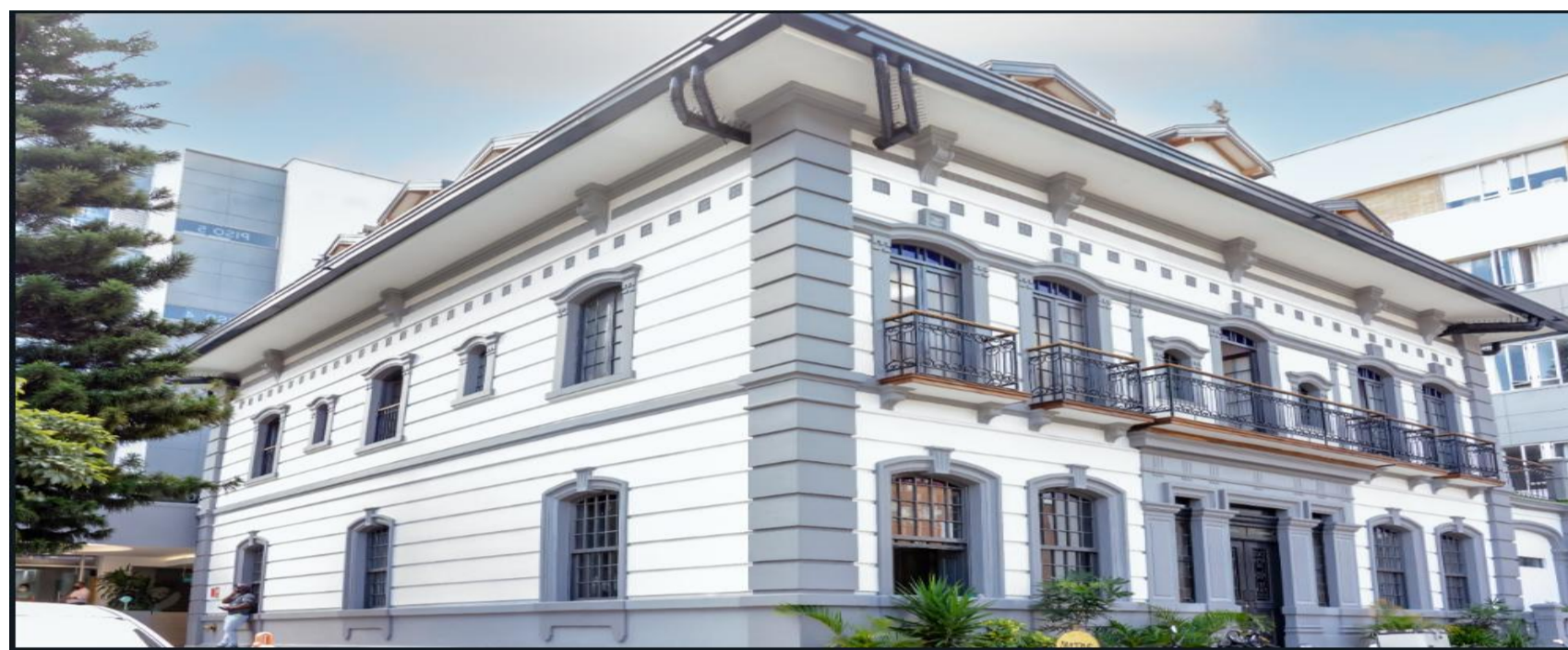
Foto 1. Estructura arquitectónica Nueva Clínica Sagrado Corazón.
