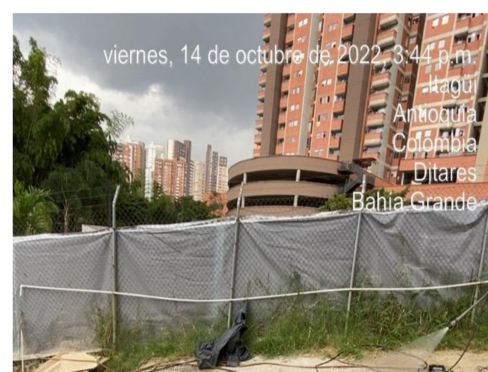
Registro fotográfico 4: Implementación de sistema de recirculación de agua.
