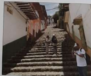
Las escaleras están compuestas por piedras de río y mortero sencillo
