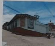
Fig. 5 Edificio de Jericó (Google Street View)
