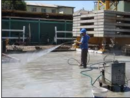
Humedades de obra
