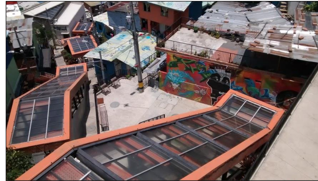
Escaleras eléctricas. Proyecto Urbano Integral PUI Comuna 13
