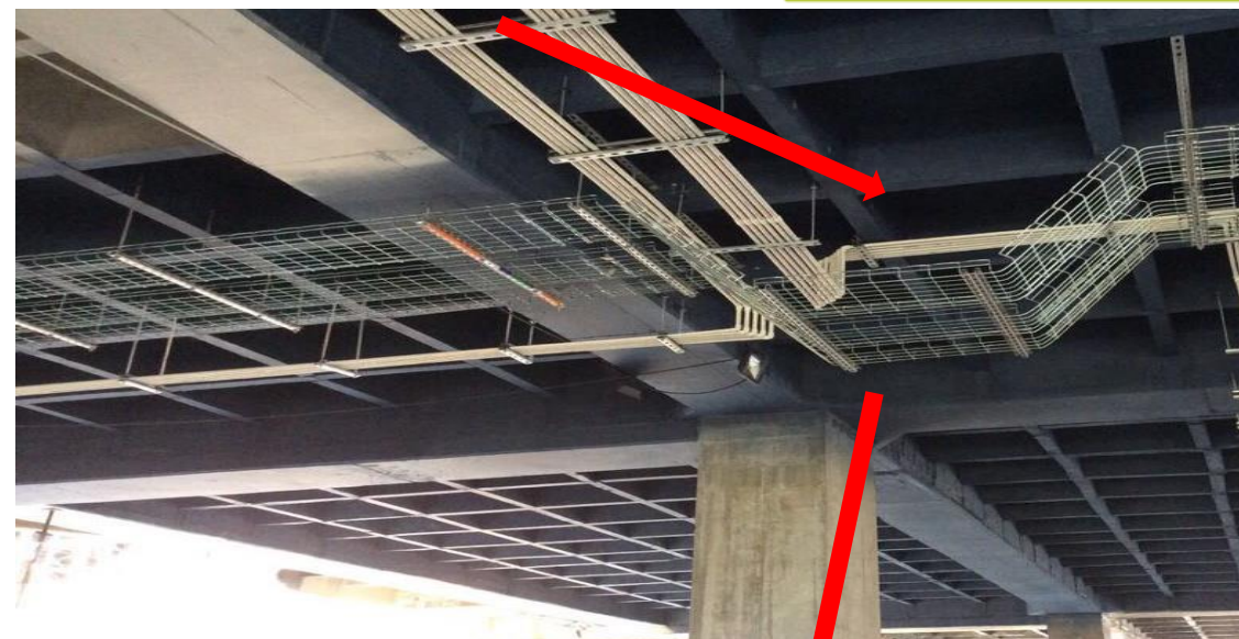
Obra en ejecución
