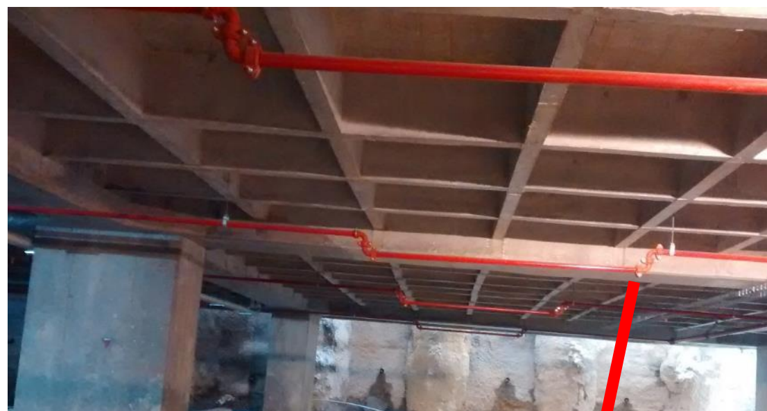
Obra en ejecución
