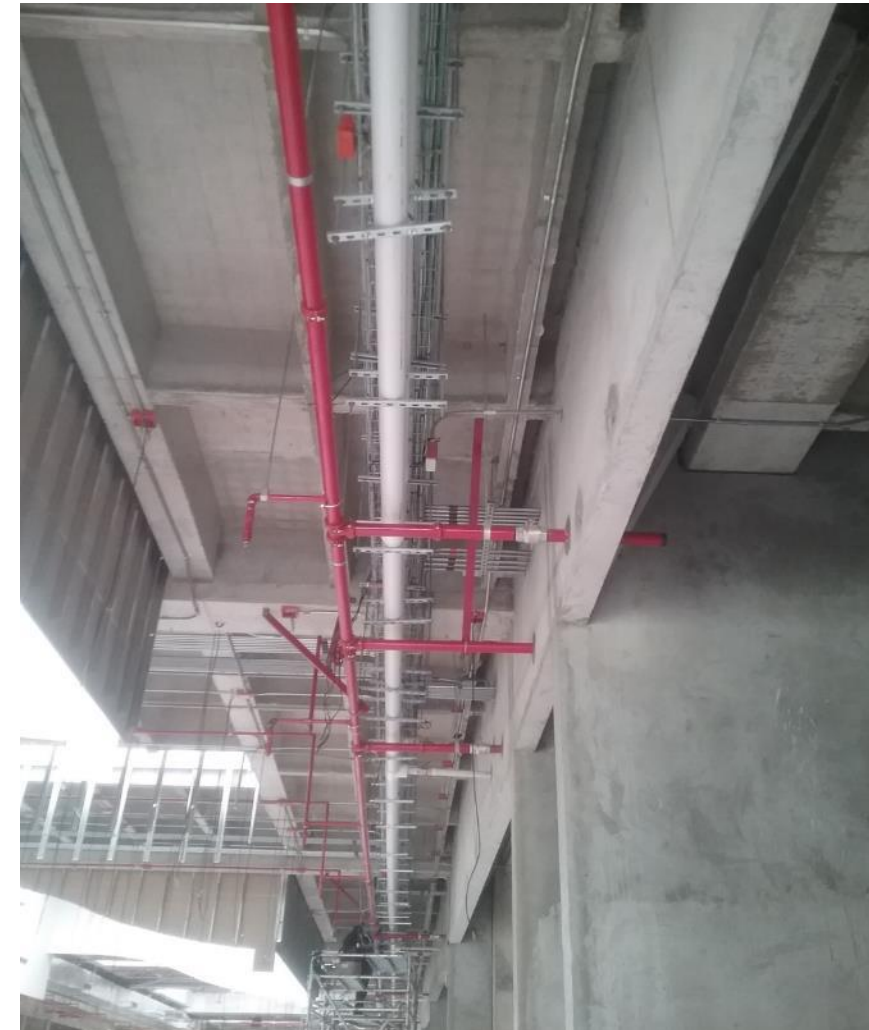
Obra Construida según detalle de coordinación
