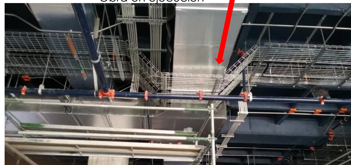
Obra Construida según detalle evitando reproceso
