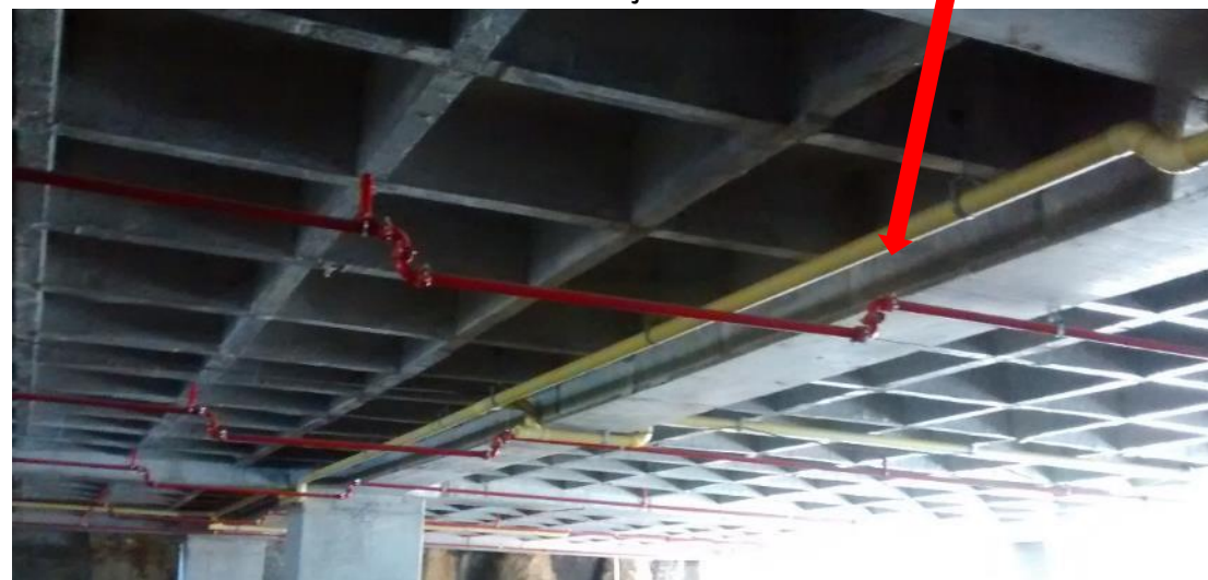
Obra Construida según detalle evitando reproceso
