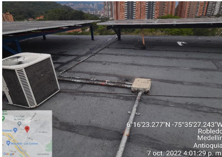
Imagen 1. Detalle elementos para reparación en cubierta de laboratorios.
