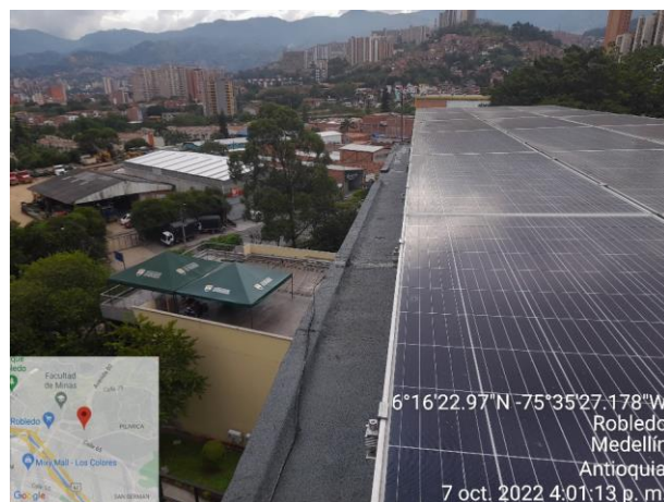
Imagen 2. Detalle elementos para reparación en cubierta de laboratorios.
