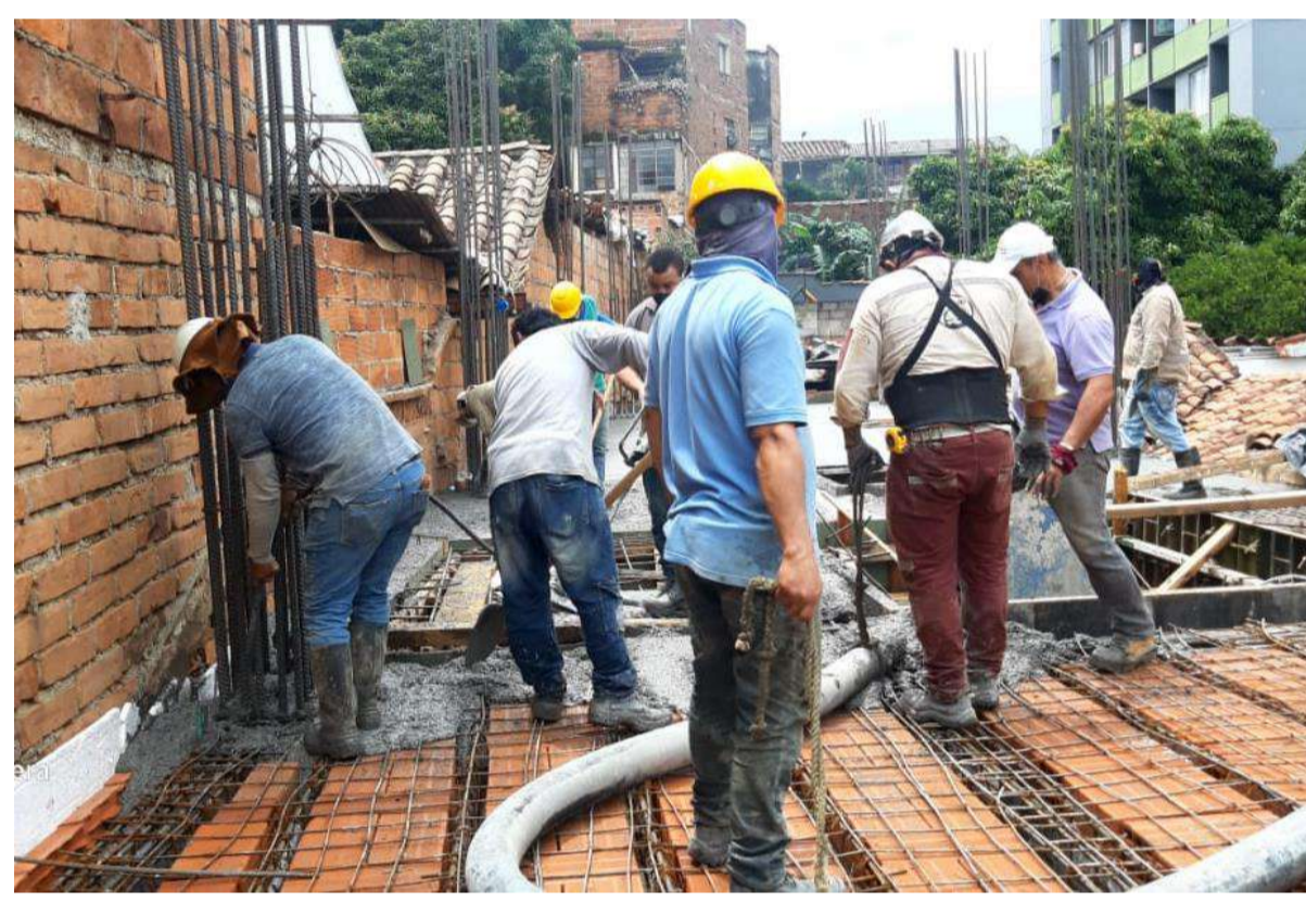
Formaleta y vaciado del concreto en visita a obra
