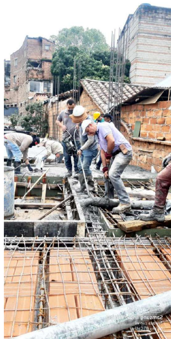
Formaleta y vaciado de concreto en visita a obra
