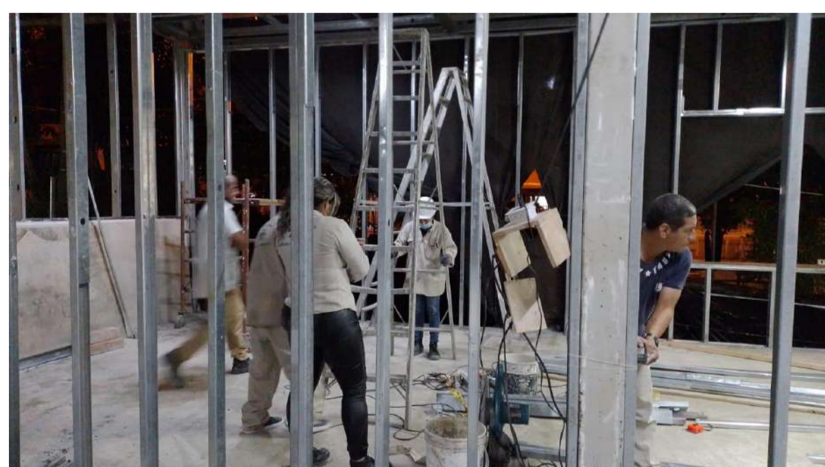
Construcción de muros en sistema liviano drywall
