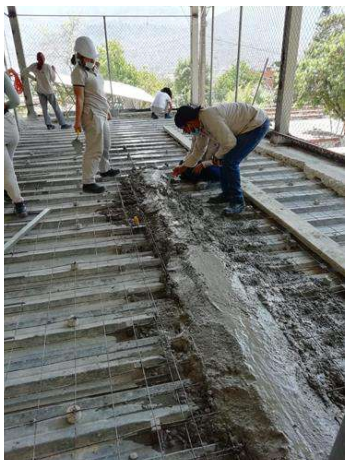
Construcción de fajas guías
