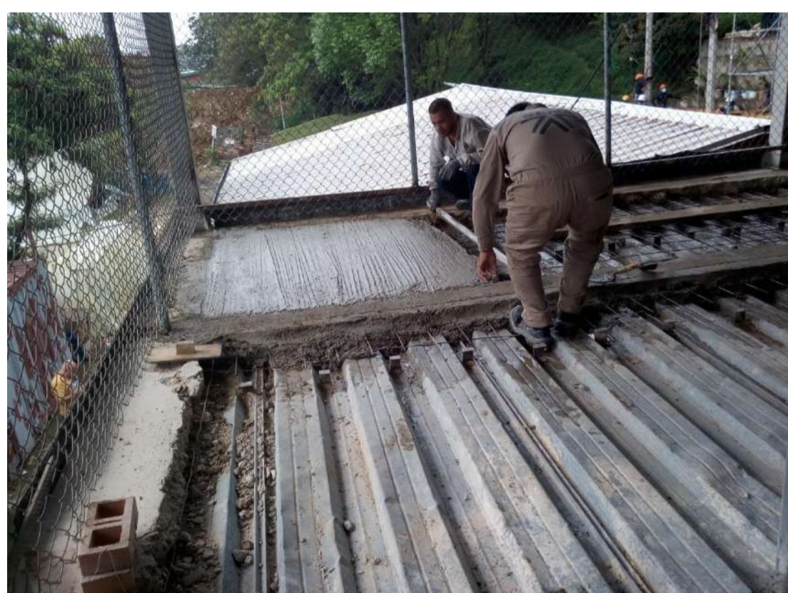
Vaciado y recorrido del concreto
