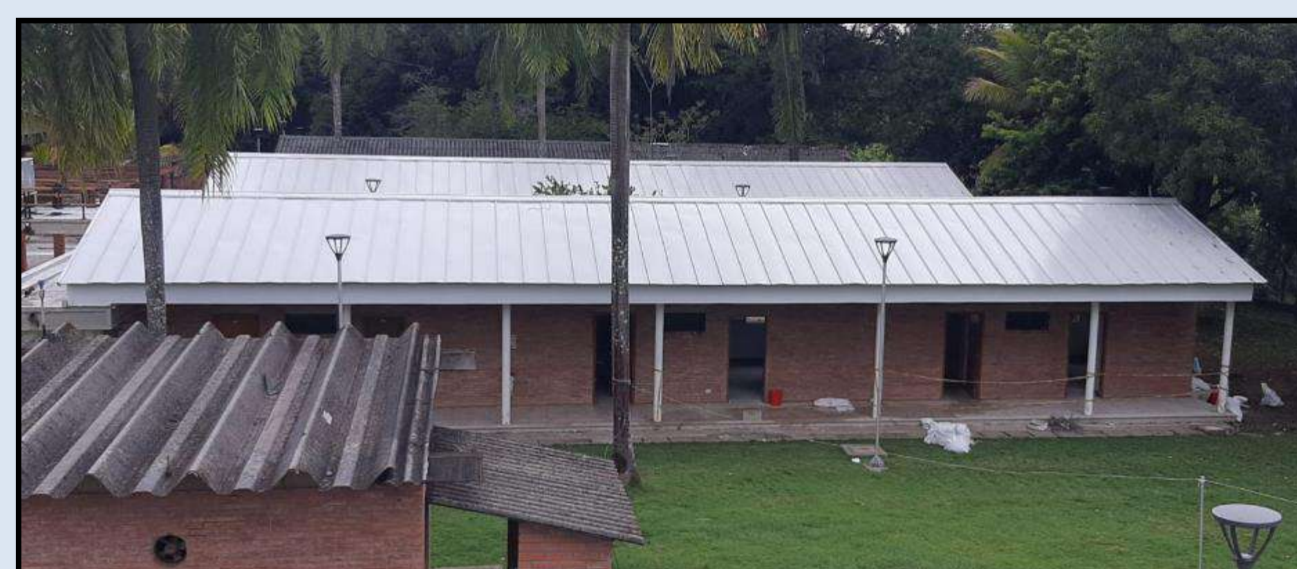
Cubiertas metálica con teja termo acústica tipo standing seam.
