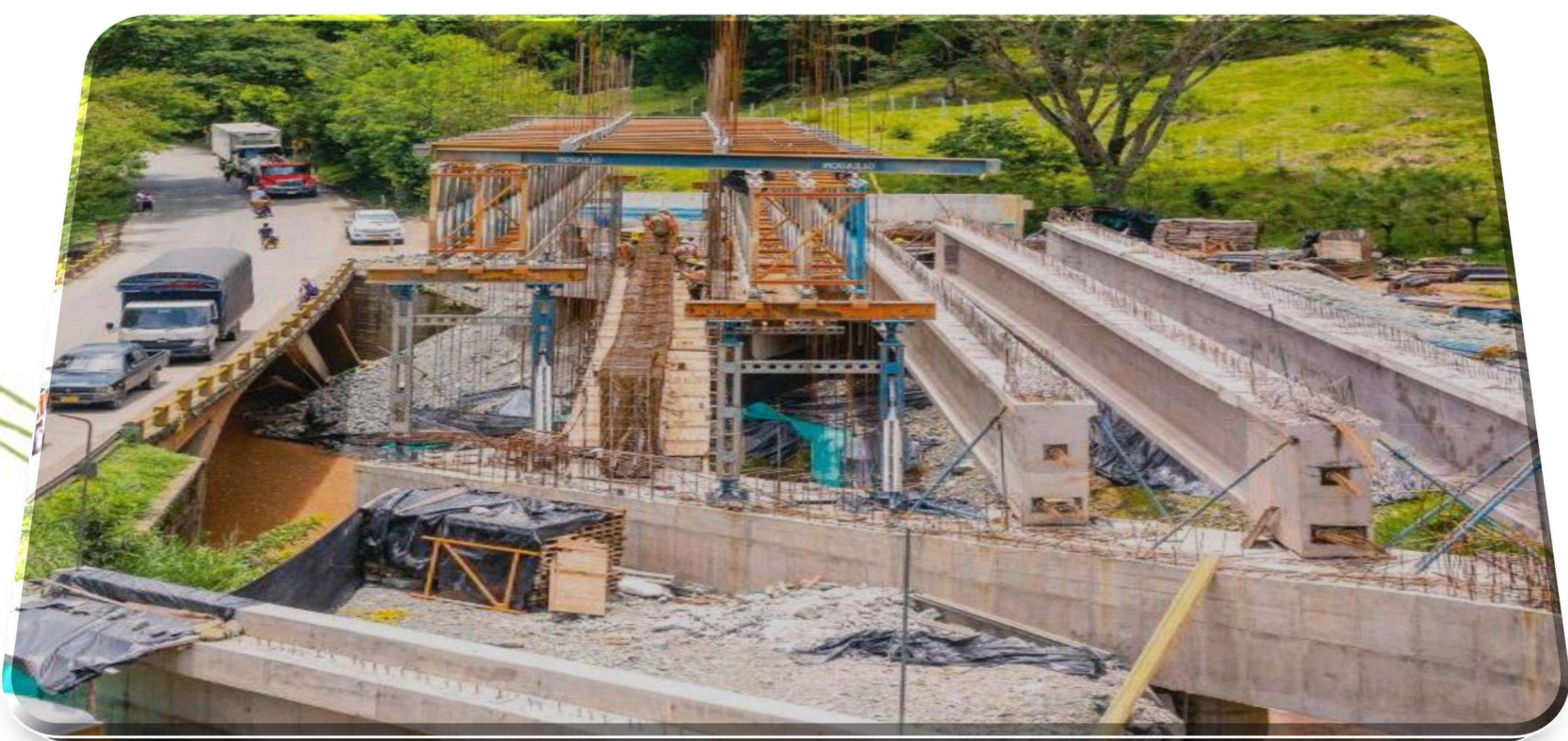
Figura 3. Mejoramiento de vías secundarias
