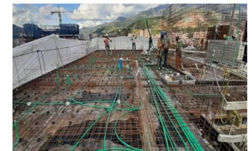
Foto 1. Instalación de acero losa.
