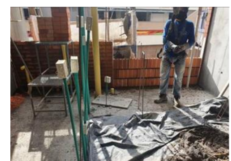
Foto 4. Pega de mampostería de fachada.
