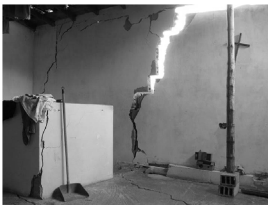
Figura 6: Inclinación de la grieta. Grietas diagonales. Fuente: propia
