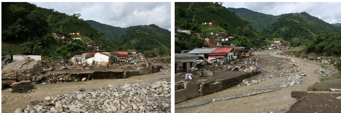
Fotografía 1 y Fotografía 2. Impactos de la avenida torrencial del 18 de mayo de 2015
