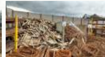
Escombros, madera y material de excavación
