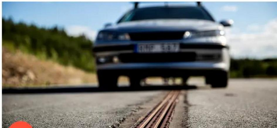
El tramo de la carretera a las fueras de Estocolmo transfiere energía desde los rieles en la carretera, recargando las baterías de los coches eléctricos y camiones.
