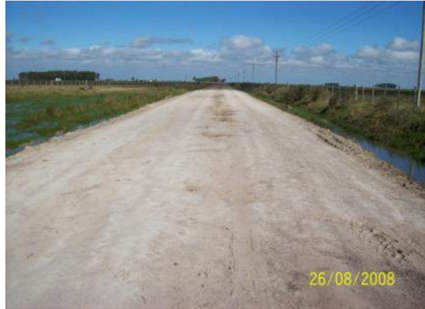
Baja adherencia entre la llanta y el pavimento corregido con cobertura de grava
