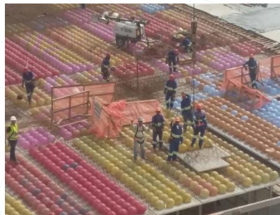
Placas prefabricadas posicionadas antes de la colocación de armazón "in situ"
