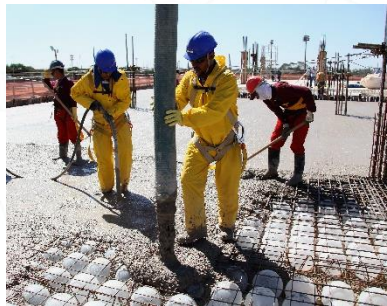
Vaciado de concreto
