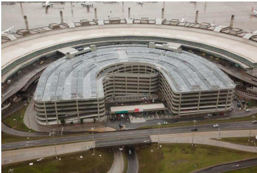
Aspecto final de la obra - GALEÃO
