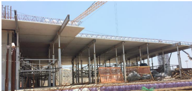
Placas montadas sobre el apuntalamiento
