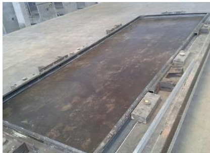
Limpieza y aplicación de desmoldante en las formaletas
