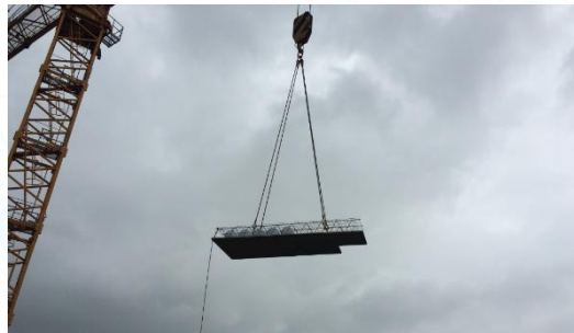
Izaje de placas prefabricadas en puntos predeterminados
