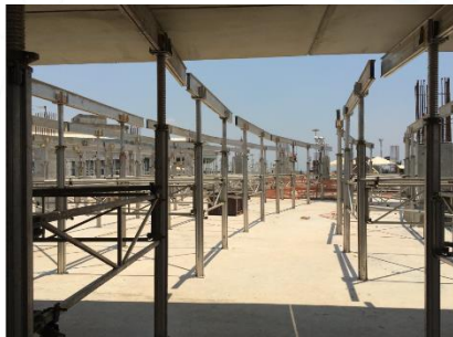
Montaje de apuntalamiento
