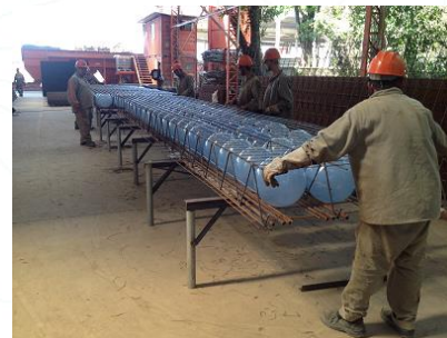
Fijación de las mallas con las esferas
