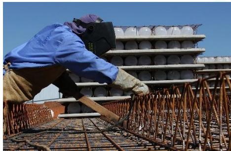
Armado de mallas y cerchas
