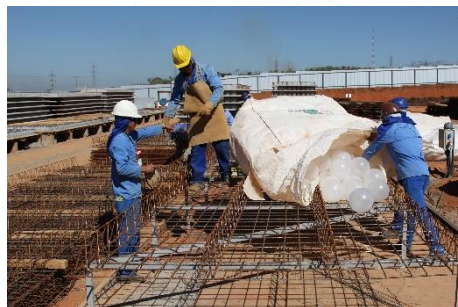
Posicionamiento de las esferas
