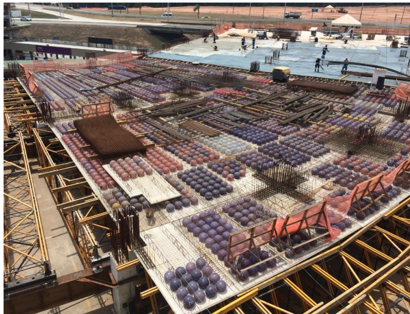
Tramo con placas posicionadas y capitales siendo armados
