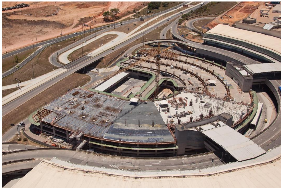
Vista general de la obra – ejecución del 4º piso
