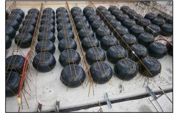
Losa lista para vaciado de concreto 1
