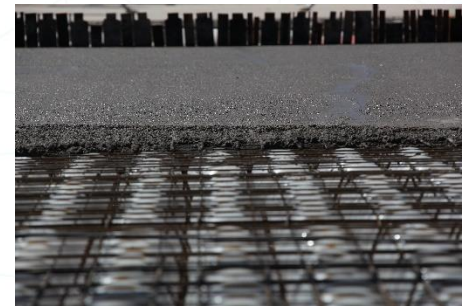
Acabado de la losa
