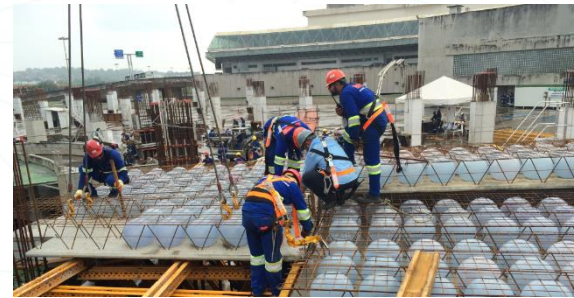
Posicionamiento de las placas prefabricadas
