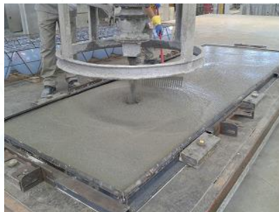
Vaciado de concreto
