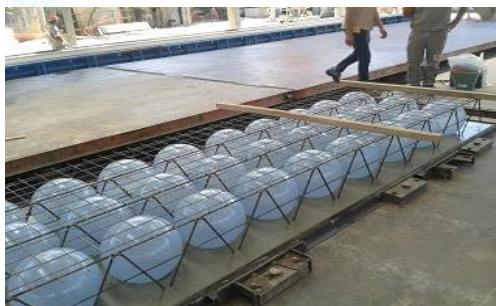
Introducción en los módulos de concreto
