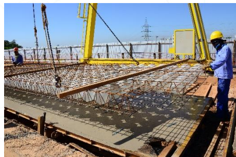
Vaciado de concreto
