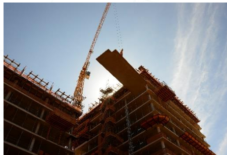
Izaje de la pre-losa
