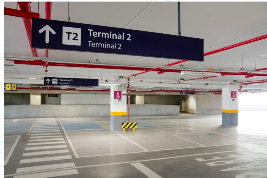
Aspecto final de la obra - GALEÃO
