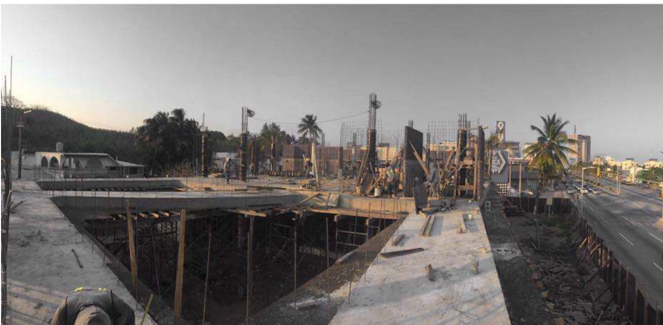
Proceso constructivo “Bomberos Boca”, Archivo Taller Diez 05
