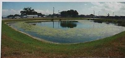
Deposiciones diseñadas para frenar durante unas horas la escorrentía de las tormentas y permitir la sedimentación de los sólidos en suspensión y con ello la reducción de la contaminación.
